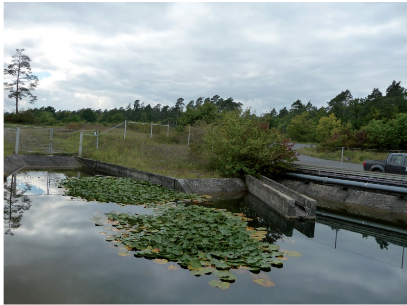
Abb. 140: Auf dem ehemaligen Standortübungsplatz Mellrichstadt wurde eine ehemalige Panzerwaschanlage in ein Biotop verwandelt (Bild: © DBU Naturerbe/ Dr. Uwe Fuellhaas).
