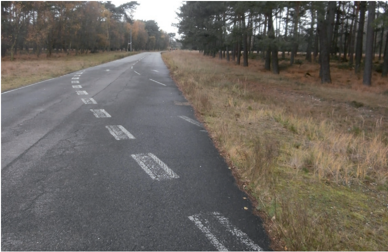
Abb. 110: Abzweigung ins ‚Nichts‘ im Brachter Wald, entstanden durch den nur teilweisen Rückbau von Wegen (Foto: V. Butt).
