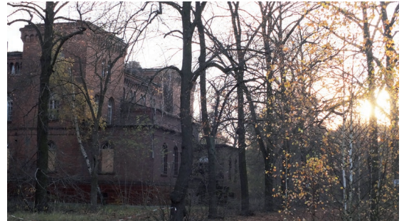
Abb. 266: Im Süden des Geländes befinden sich denkmalgeschützte Gebäude aus der Kaiserzeit, die zusehends verfallen. Sie zeugen von den Anfangsjahren des Areals als Schießplatz (Foto: V. Butt).
