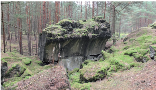
Abb. 267: Im Wald finden sich bis heute Relikte der militärischen Testanlagen, wie hier beim „Vereinigten Panzer- und Gewölbeziel“ (Foto: V. Butt).
