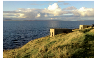
Abb. 5: Spähposten des Atlantikwalls auf den Orkney Islands (Foto: V. Butt).
