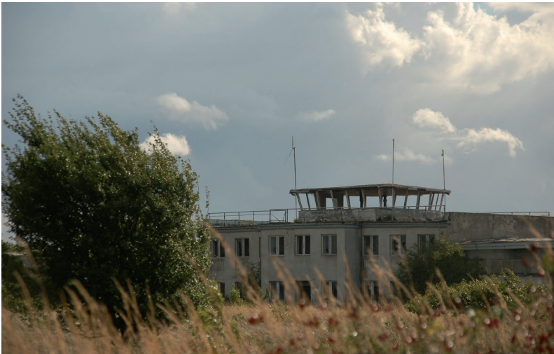
Abb. 243: Angrenzend an das ehemalige Flugfeld errichtete die sowjetische Armee ein towerähnliches Gebäude, das als Feuerleitzentrale der Flakartillerie diente (Feiler und Feiler 2004, 90) (Foto: W.-P. Polzin).
