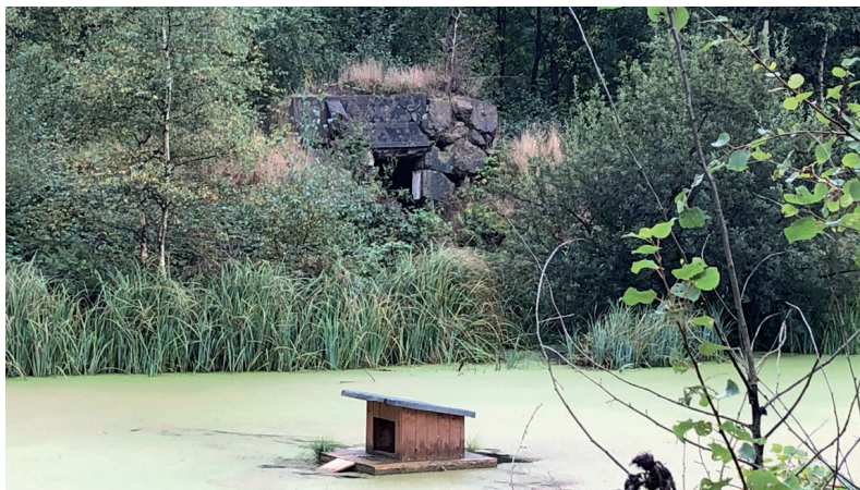
Abb. 57: Versteckt im Wald, jahrzehntelang unbeachtet: Im Hintergrund Relikte einer Pumpenstation am Löschteich des ehemaligen Heerestanklagers Bekenau in Herbram-Wald (Foto: V. Butt).
