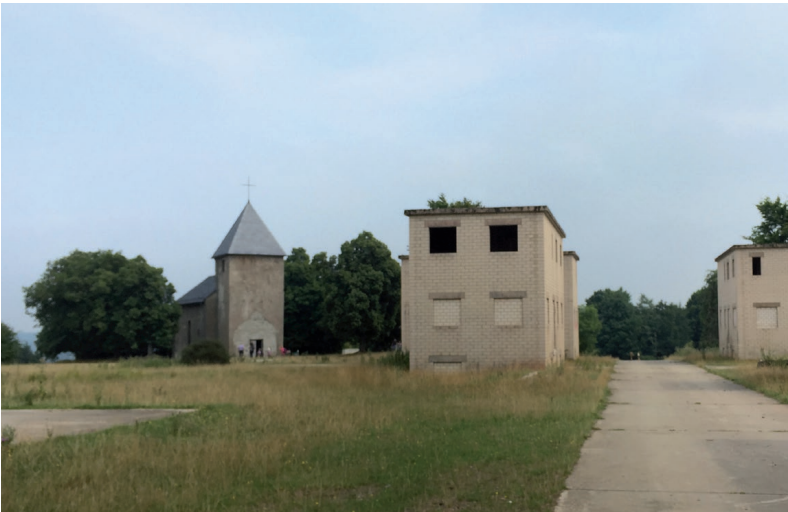
Abb. 40: Die im Übungsbetrieb stark beschädigte ehemalige Dorfkirche von Wollseifen wurde teilweise rekonstruiert. Die Schäden am Kirchengebäude sind auch nach der Wiederherstellung noch sichtbar. Der für die ehemaligen Dorfbewohnerinnen und -bewohner wichtige Ort liegt neben den ebenfalls erhalten gebliebenen militärischen Übungsgebäuden (Foto: M. Blaas).
