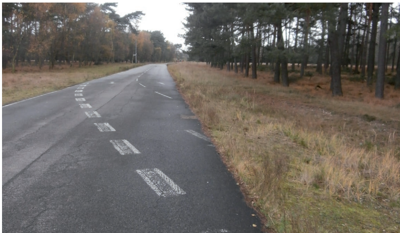
Abb. 327: Nach der Unterschutzstellung des Areals wurden zahlreiche, aber nicht alle, Bodenplatten der Gebäude sowie 10 km Asphaltstraßen zwecks Entsiegelung zurückgebaut (Kolshorn 2018). Auf den verbliebenen Bodenplatten wärmen sich Reptilien (ebd.). Die Fahrbahnmarkierungen auf den Wegen blieben bewusst erhalten (ebd.) (Foto: V. Butt).
