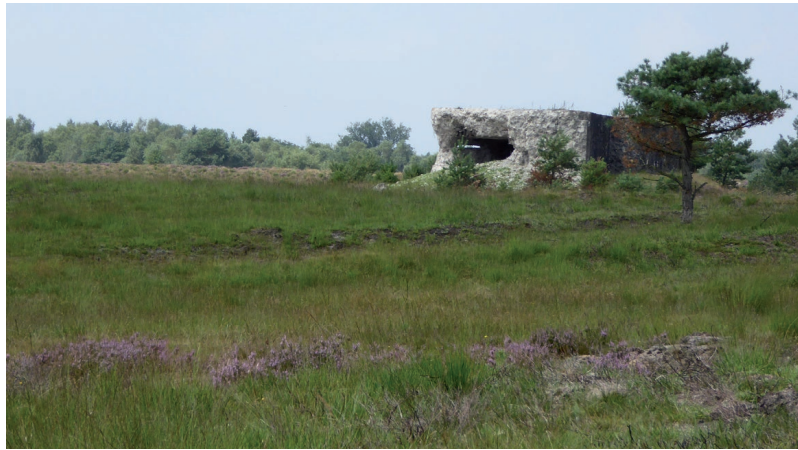
Abb. 7: Ein Betonbunker auf dem Truppenübungsplatz Senne dient als ‚Hartziel‘ für Schießübungen (Foto: V. Butt).
