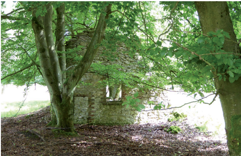
Abb. 43: Zerstörtes Gebäude auf dem Truppenübungsplatz Senne. An Standorten von Ruinen entstehen neue Baumgruppen (Foto: V. Butt).
