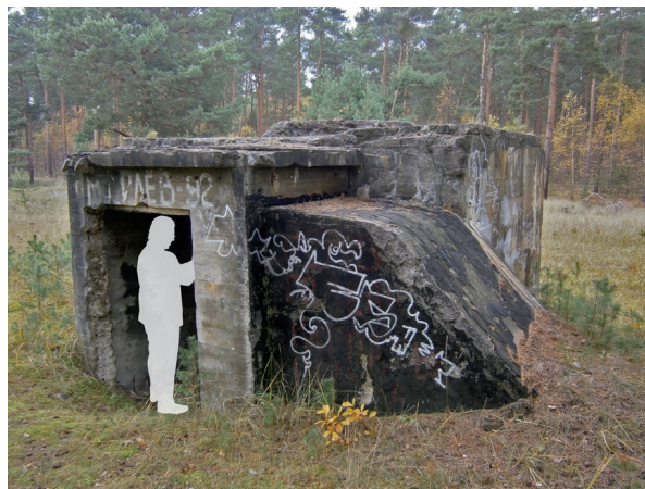
Abb. 213: (rechts) Niels Niemeyer schlägt vor, einen Teil der Gebäude und militärischen Relikte zu sichern, damit Besucherinnen und Besucher sie eigenständig erkunden und auch betreten können (Visualisierung: N. Niemeyer).
