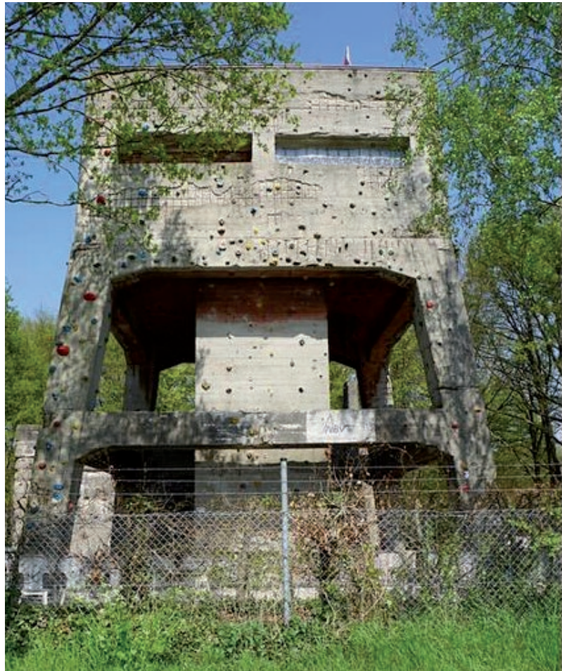
Abb. 141: Der Flugleitungsturm des ehemaligen Fliegerhorstes in der Venloer Heide dient heute als Kletterturm (Foto: N. Schmitz/ Landschaftsverband Rheinland (Ausschnitt)).
