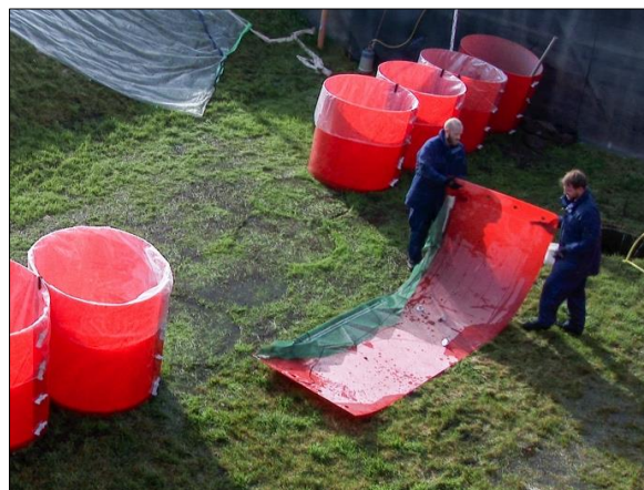
Abb. D-86: Aquariwa – Rückbau, Arbeitsschritt 5: Öffnen des Zylinders und Bereitstellen für den Abtransport
