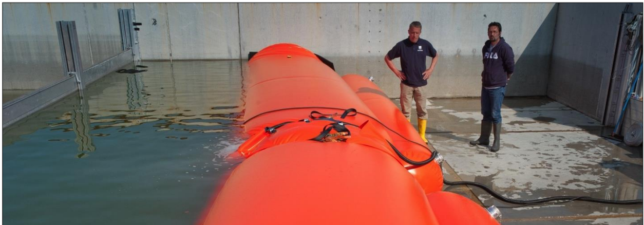
Abb. 6-9: Standsicherheitsprüfung des Schlauchsystems Flutschutz-Doppelkammerschlauch durch den Technischen Überwachungsverein TÜV (Foto: Manfred W. Jürgens)
