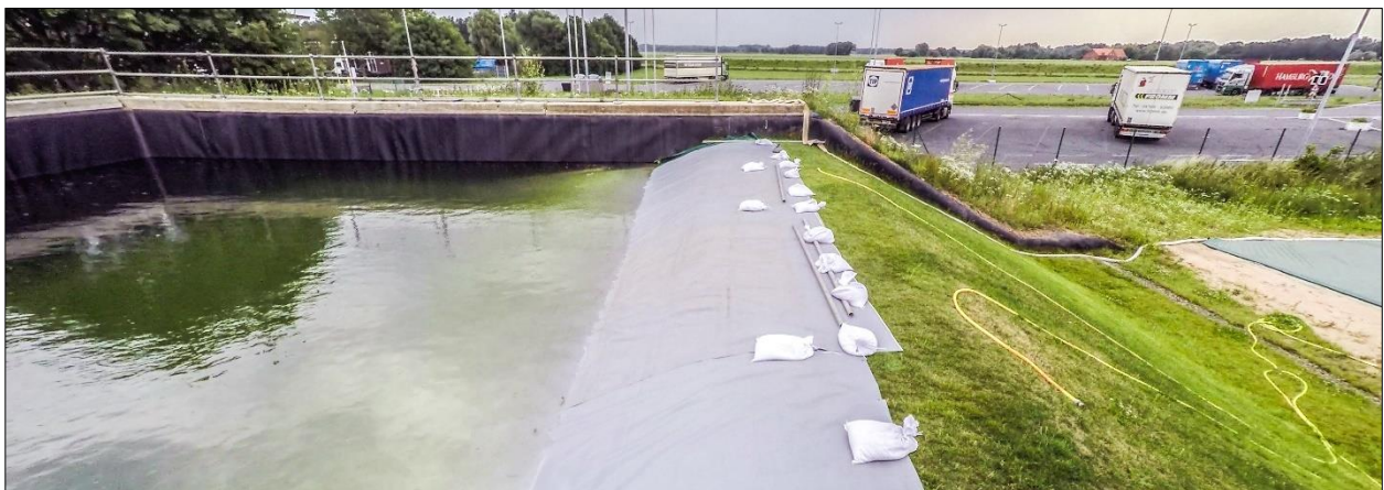
Abb. 5-17: Einstauversuch 2 – Installiertes Schutzsystem
