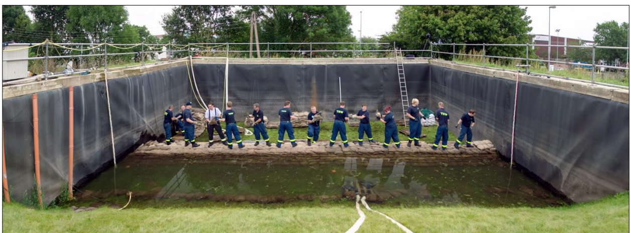
Abb. 7-11: Sandsackdamm – Rückbau der 8. Lage durch Einsatz von THW-Helfern
