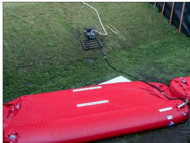
Abb. 7-23: Flutschutz-Doppelkammerschlauch – Rückbau, Arbeitsschritt 1: Entleeren der Kammern durch Pumpeneinsatz
