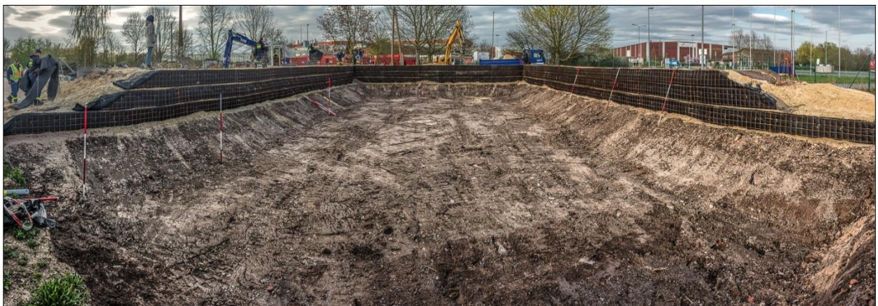
Abb. B-13: Kunststoffbewehrter Erdwall – Aufbau der dritten Lage
