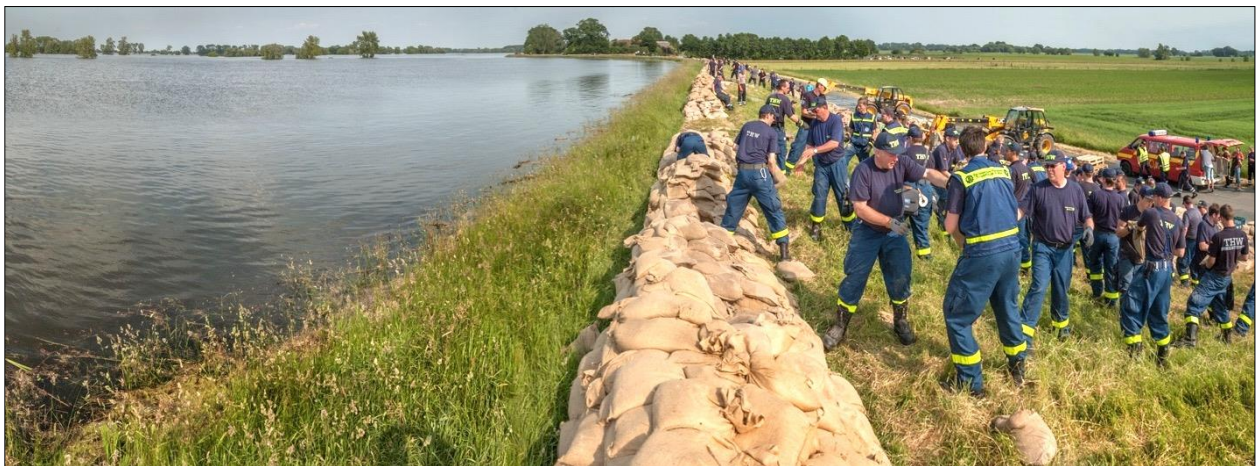
Abb. 3-14: Rückbau einer Sandsack-Aufkantung und Aufbau eines Auflastfilters am binnenseitigen Deichfuß beim Elbehochwasser 2013 in der Nähe von Hitzacker (Foto: Bärbel Koppe)
