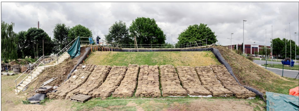
Abb. 5-33: Fertiggestellter Sandsack-Auflastfilter
