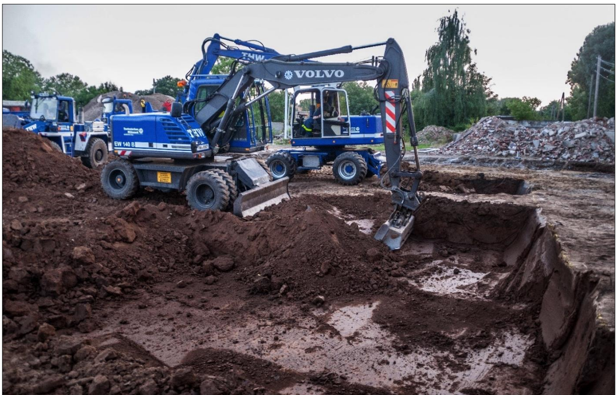
Abb. B-5: Erstellung der Baugrube des Testgeländes
