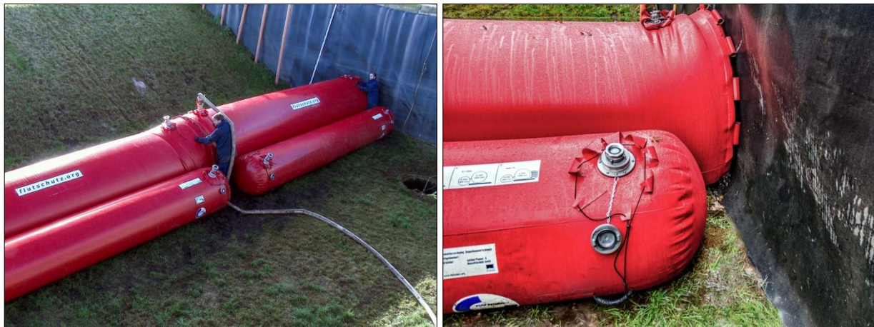
Abb. 7-16: Flutschutz-Doppelkammerschlauch – Aufbau, Arbeitsschritt 7 und 8: Wasserbefüllung der großen Kammern bei gleichzeitiger Entlüftung (links); Abdichtung des Randbereichs durch eigenständiges Anpressen der Stirnseite (rechts)
