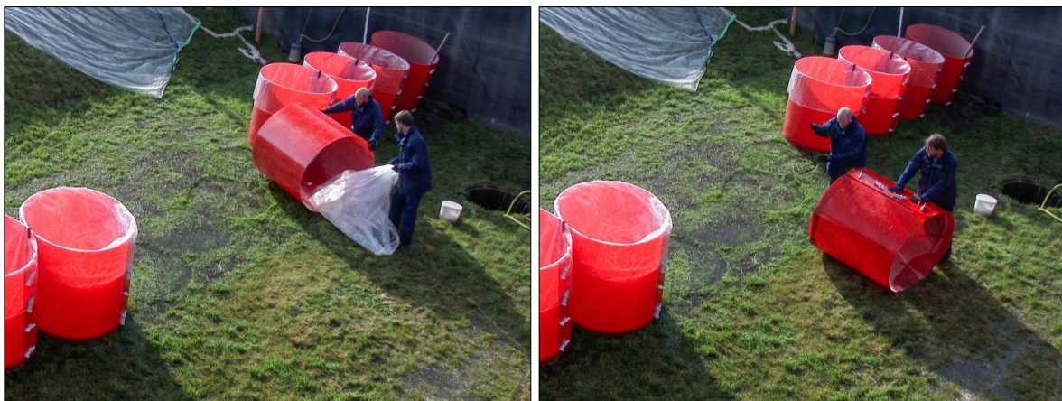
Abb. D-85: Aquariwa – Rückbau, Arbeitsschritte 3 und 4: Kippen des Systemelementes und Entnahme des Foliensacks (links); Lösen des Gitternetzes und der Verbindungselemente (rechts)
