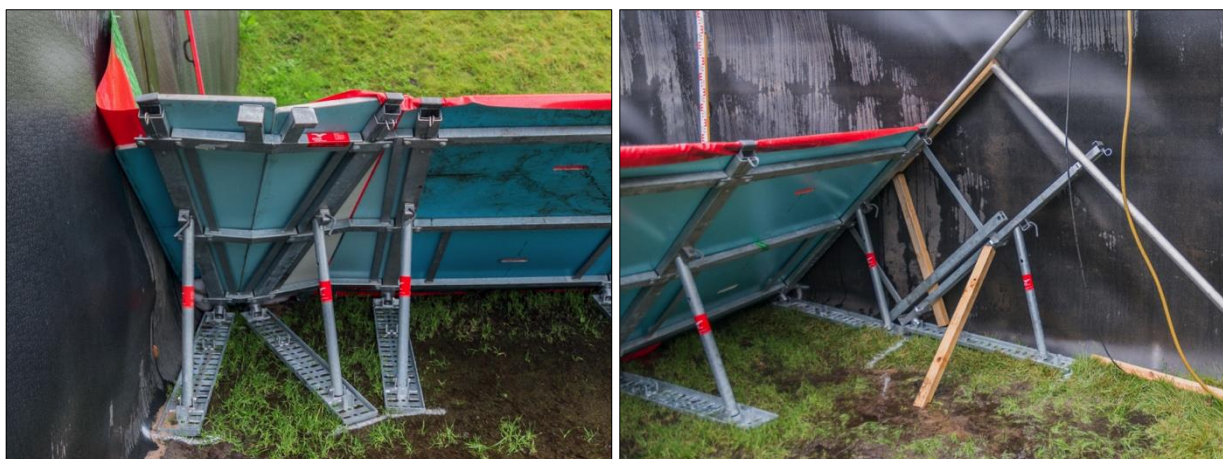
Abb. D-125: Plettac Aqua Defence – Aufbau: Schließen der Restlänge mithilfe von Eckelementen (links); Aussteifung des Randbereichs mit Holzlatten und Metallstangen
