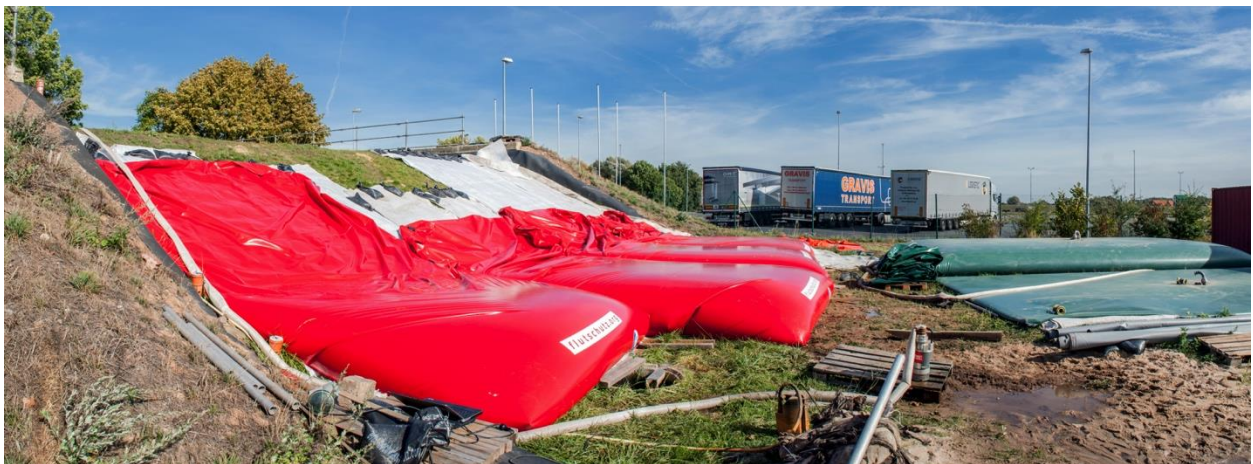
Abb. 5-41: Seitenansicht des fertiggestellten Flutschutz-Auflastfilters
