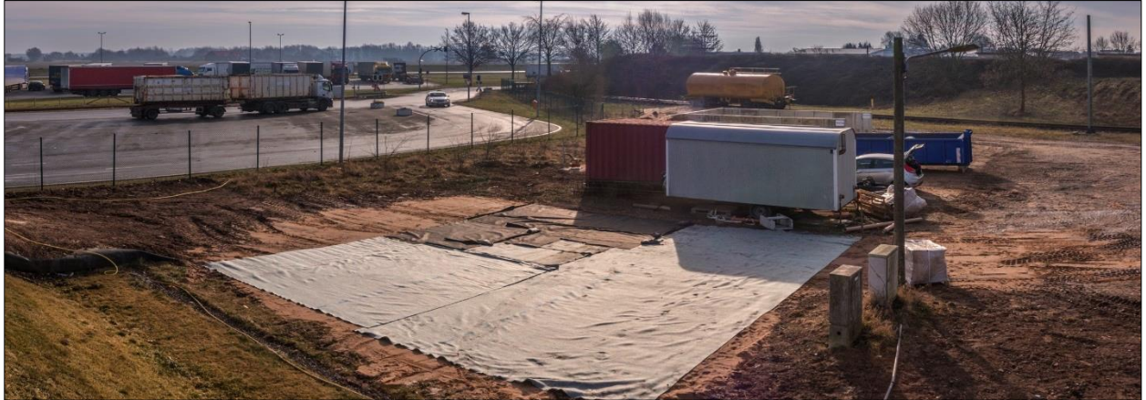
Abb. B-38: Aufbringen eines Schutzvlieses zum Schutz der Wasserspeicher
