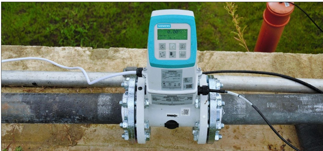
Abb. B-35: Magnetisch-Induktiver-Durchflusssensor (Siemens, Typ: SITRANS F M MAG 5100 W)
