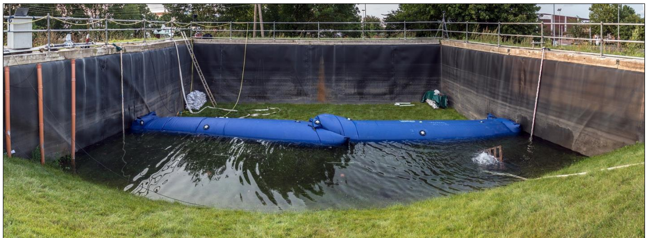
Abb. D-8: Hydrobaffle – Belastungstest: Einstau mit einem Wasserstand von 0,69 m
