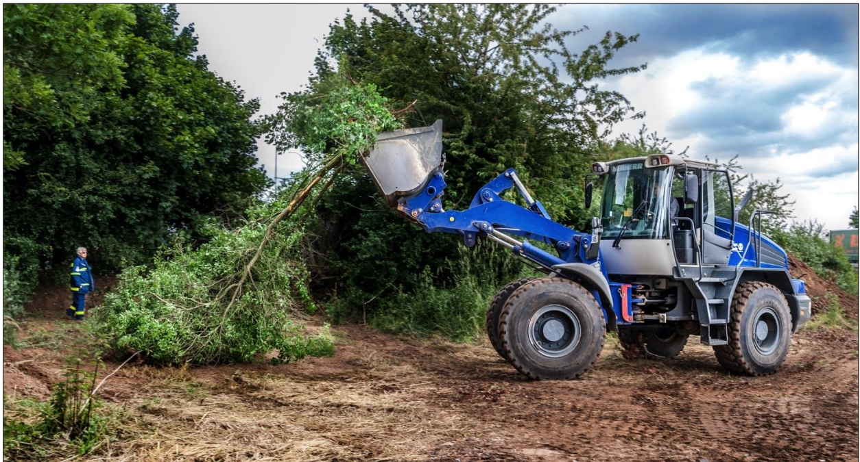
Abb. B-2: Entfernung des Baumbestands im Bereich der geplanten Testanlage
