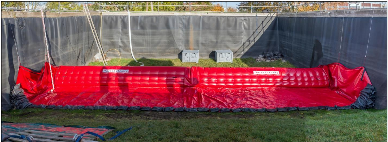
Abb. D-66: Flutschutz-Deichkade – Aufbau: Fertiggestellte Schutzlinie
