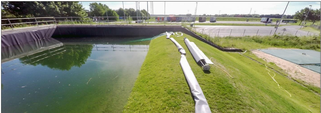
Abb. 5-16: Einstauversuch 2 – Aufbringen mit Hilfe des Planenrollers vom THW
