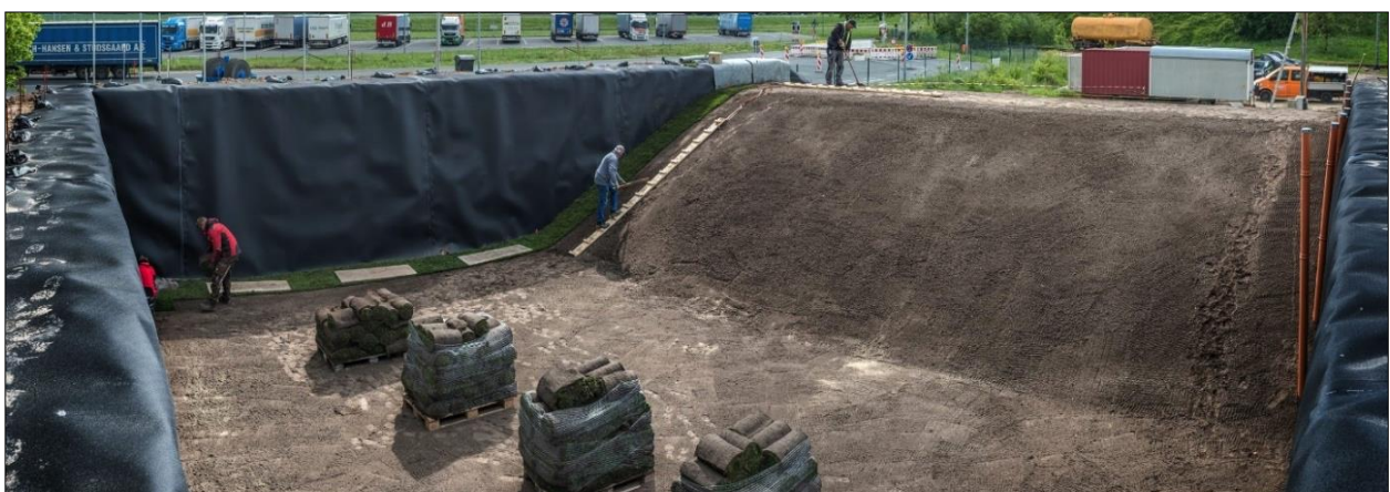
Abb. B-25: Einbau des Rollrasens
