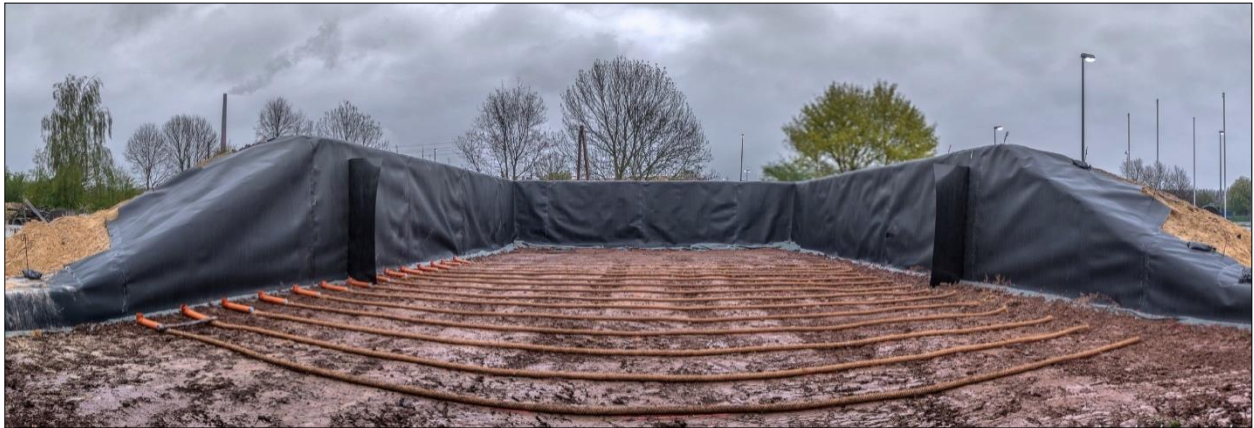
Abb. B-21: Installation der Drainageleitungen
