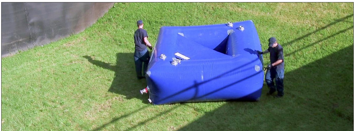
Abb. 5-51: Arbeitsschritt 2 – Positionierung der Flutschutz-Quellkade über der Schadstelle
