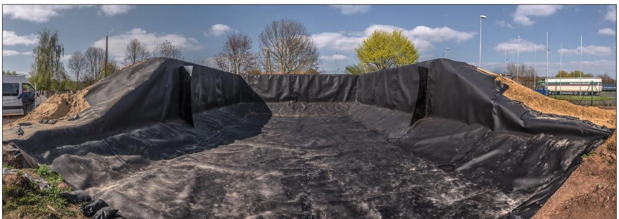
Abb. B-18: Dichtung mit einer Kunststoffdichtungsbahn
