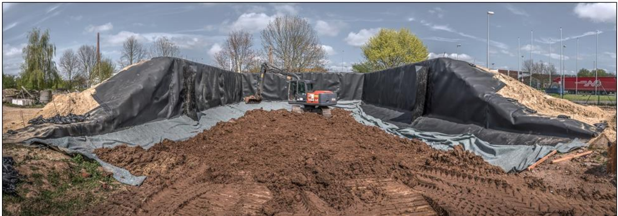
Abb. B-19: Einbau der Auelehmschicht
