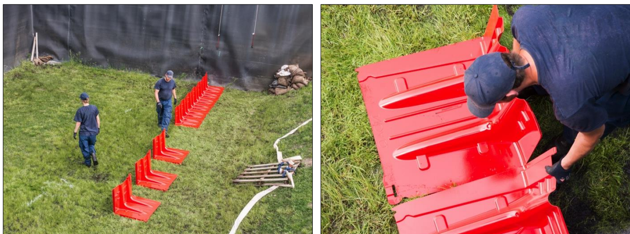
Abb. D-138: NOAQ Boxwall – Aufbau, 1. und 2. Arbeitsschritt: Kunststoffwinkel verteilen und mit der Dichtung nach unten aufstellen (links); Verbinden der Systemelemente (rechts)
