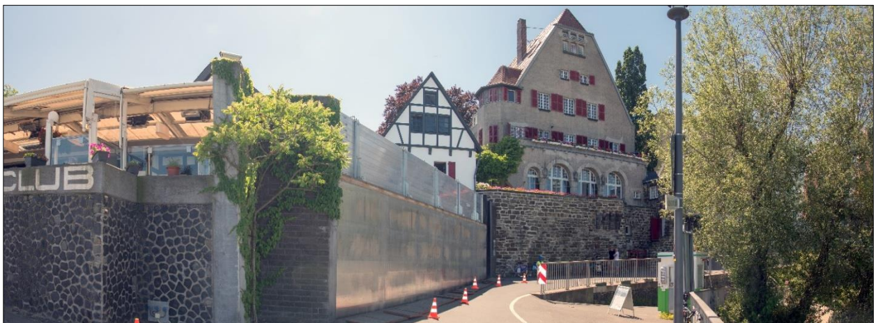
Abb. 6-3: Mobile Hochwasserschutzwand kombiniert mit einem Dammbalkensystem in Köln-Rodenkirchen
