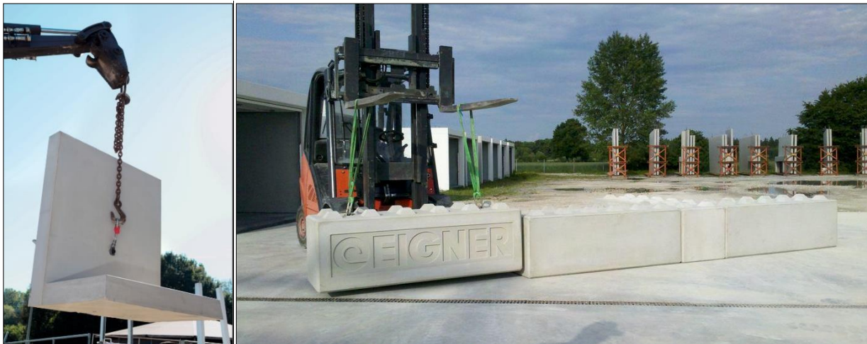
Abb. 6-14: Winkelstützwand (links), (Lithonplus, 2017); Stapelbarer Betonblock (rechts), (Eigner, 2020)
