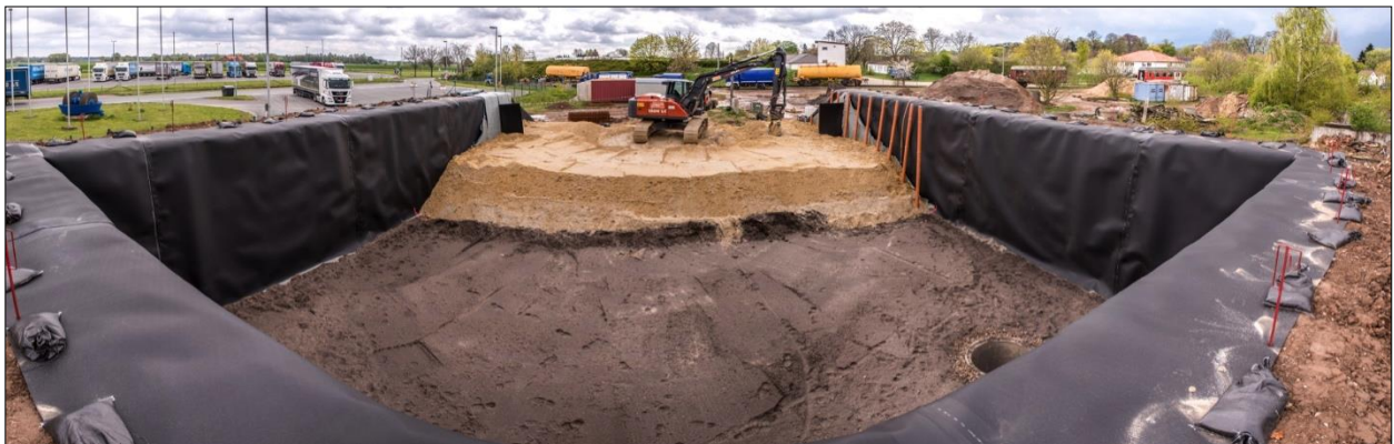
Abb. B-22: Einbau des Deichbaumaterials
