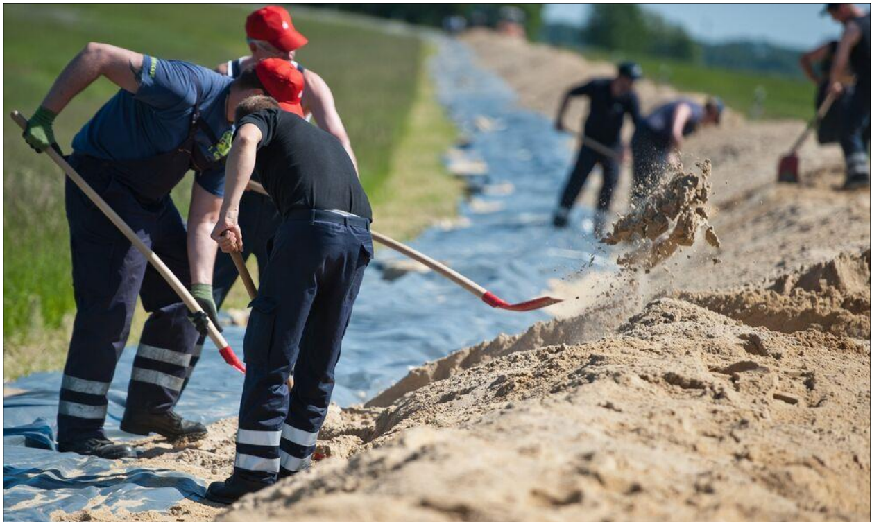
Abb. 3-12: Aufschüttung einer Aufkantung aus Sand und Folien entlang des Elbdeichs im niedersächsischen Hitzeacker (dpa/Ini, 2013)
