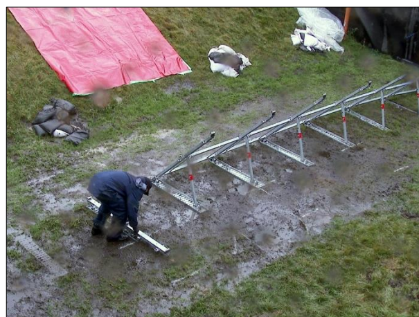
Abb. D-135: Plettac Aqua Defence – Rückbau, Arbeitsschritt 4: Lösen der Arretierung und Zusammenklappen des Stützbocks
