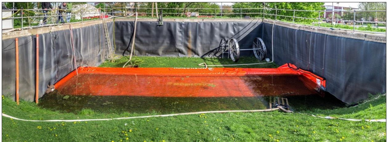
Abb. D-40: Mobildeich – Belastungstest: Einstau mit einem Wasserstand von 0,60 m
