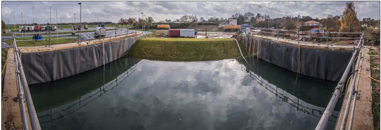
Abb. B-30: Fertiggestellte Absturzsicherung während eines Einstauversuchs
