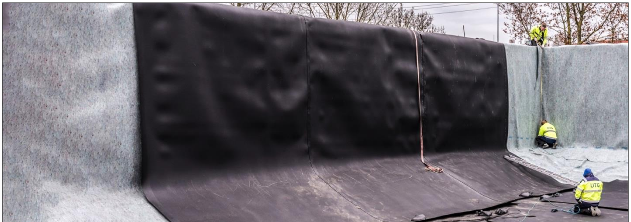
Abb. B-17: Einbau der Kunststoffdichtungsbahn
