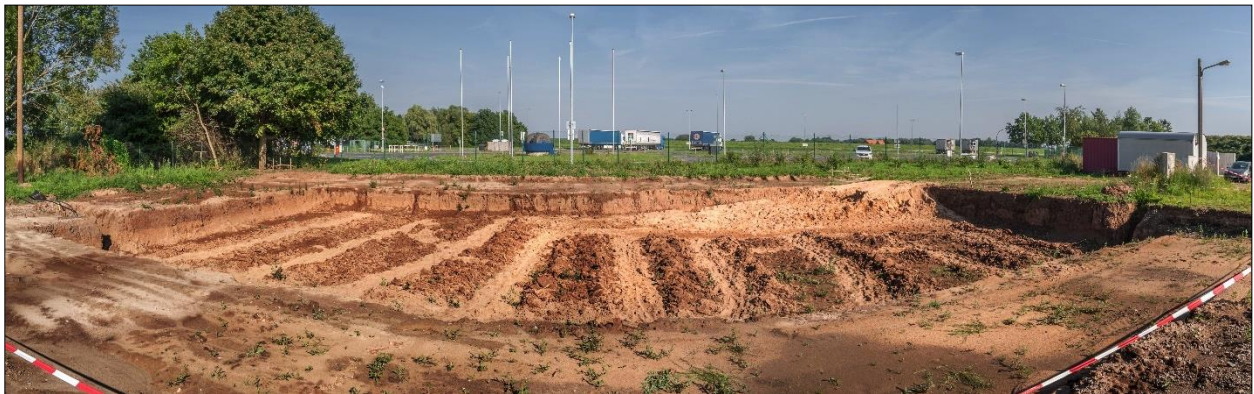
Abb. B-6: Fertiggestellte Baugrube des Testgeländes
