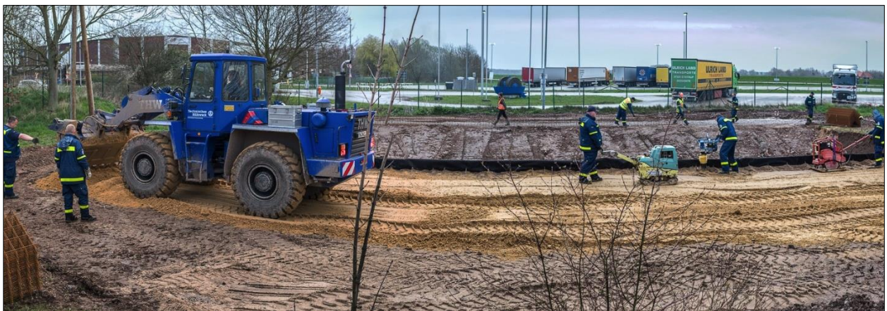
Abb. B-9: Kunststoffbewehrter Erdwall – Arbeitsschritt 4 – Einbringen und verdichten von Bodenmaterial
