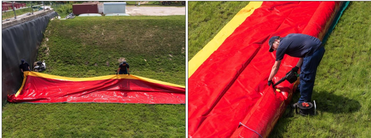
Abb. D-49: Öko-Tec-Schlauchwall – Aufbau, Arbeitsschritte 3 und 4: Ausklappen der vorgelagerten Dichtungsbahn auf die Wasserseite (links); Befüllen des Öko-Tec-Schlauchwalls mithilfe eines Luftgebläses (rechts)
