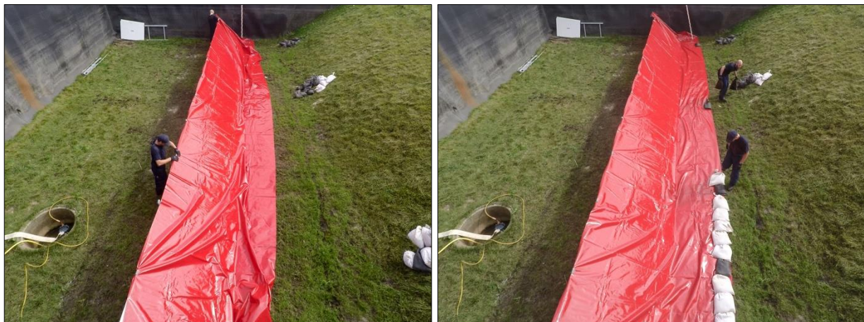
Abb. D-124: Plettac Aqua Defence – Aufbau, 7. und 8. Arbeitsschritt: Fixierung der Schutzplane und der Hartschaumplatte mit den Plattenhaltern (links); Beschwerung der Schutzplane mit Sandsäcken (rechts)
