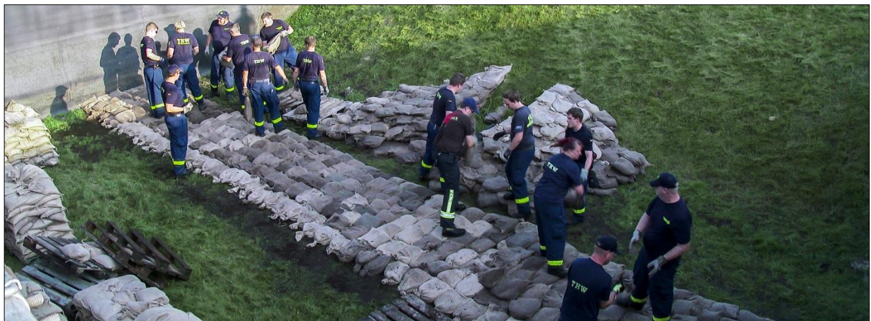
Abb. 7-2: Sandsackdamm – Aufbau der Basis
