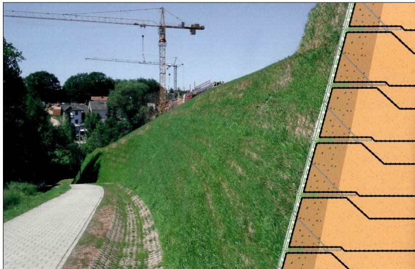
Abb. A-7: Prinzip der Kunststoffbewehrten Erde (Huesker, 2014)
