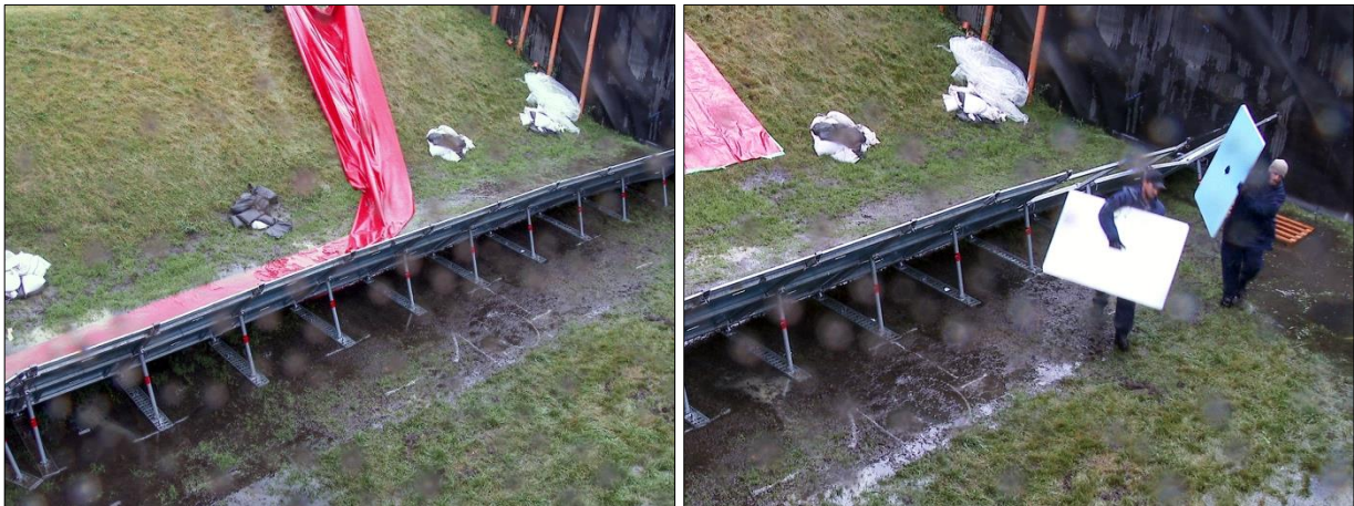
Abb. D-133: Plettac Aqua Defence – Rückbau, Arbeitsschritte 1 und 2: Entnahmen der Sandsäcke und Demontage von der Schutzplane (links); Rückbau der oberen Hartschaumplatten (rechts)
