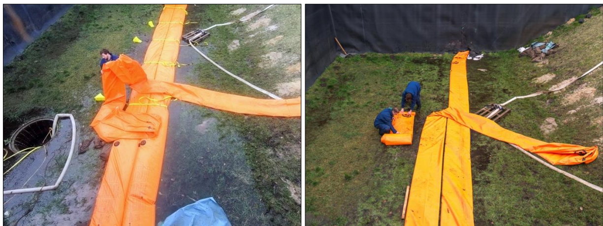
Abb. D-31: Tiger Dam – Rückbau, Arbeitsschritte 3 und 4: Entleerung der Schläuche durch anheben des Schlauchs (links); Zusammenrollen der entleerten Schläuche und Bereitstellen für den Abtransport (rechts)
