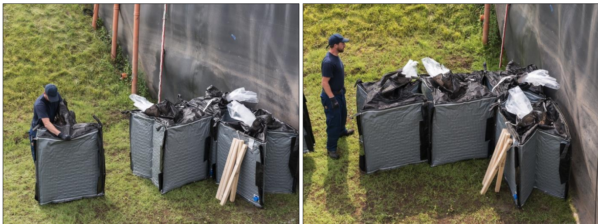
Abb. D-88: Indutainer – Aufbau, Arbeitsschritte 1 und 2: Indutainer am Einsatzort auseinanderfalten (links) und entlang der Schutzlinie positionieren (rechts)
