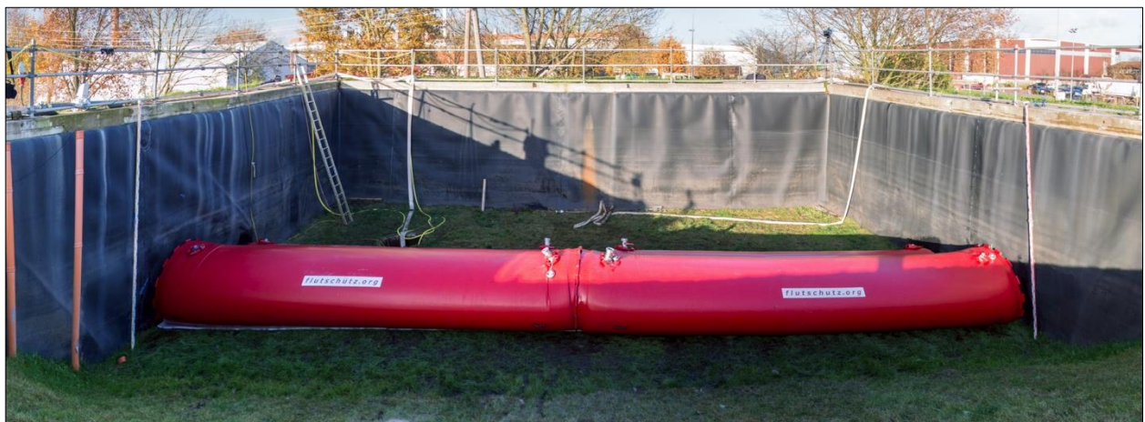
Abb. 7-17: Flutschutz-Doppelkammerschlauch – Aufbau: Fertiggestellte Schutzlinie
