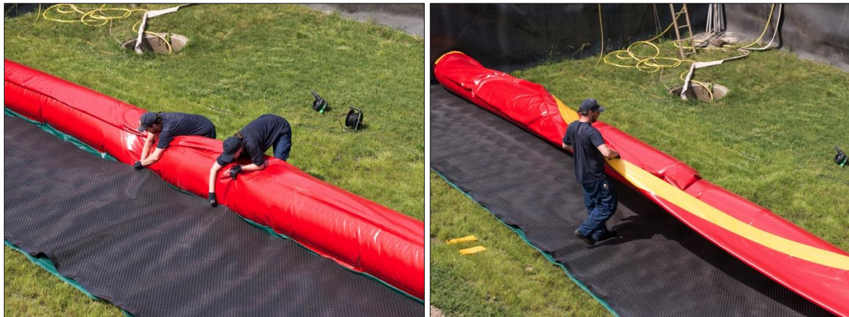
Abb. D-51: Öko-Tec-Schlauchwall – Aufbau, Arbeitsschritte 7 und 8: Ausrichten der Noppenbahn an die richtige Position (links); Zurückklappen und Ausrichten der vorgelagerten Dichtungsbahn auf der Wasserseite (rechts)
