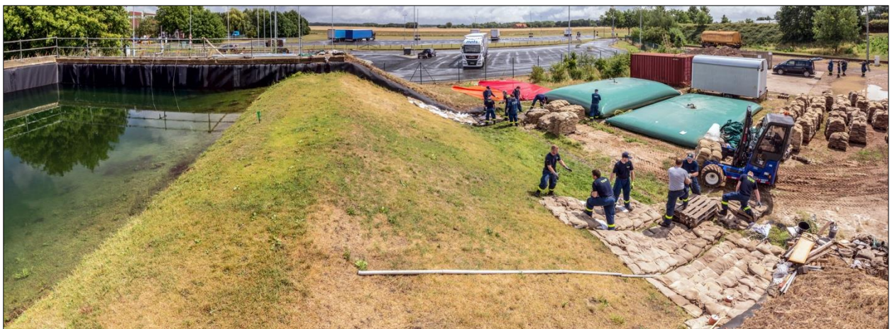
Abb. 5-31: Aufbau der ersten Lagen des Sandsack-Auflastfilters mit Helfern des THW
