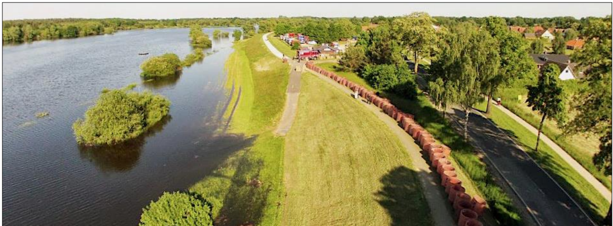
Abb. 3-16: Aufkädung durch Verwendung eines Sandsackersatzsystems an einem Hochwasserschutzdeich mit Minderhöhen (Aquariwa, 2020)
