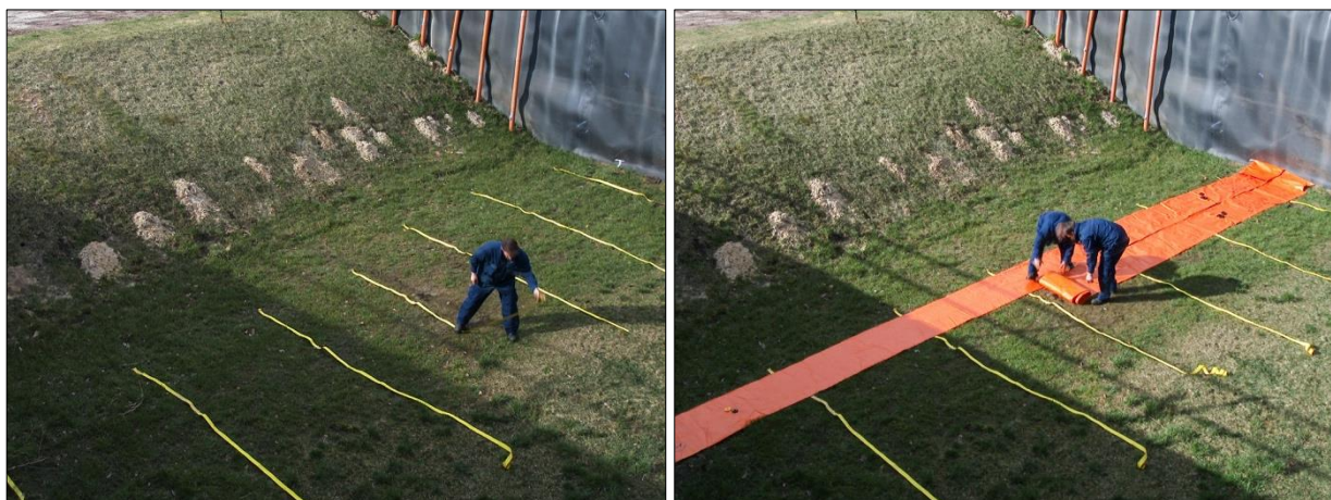
Abb. D-17: Tiger Dam – Aufbau, Arbeitsschritte 1 und 2: Auslegen der Befestigungsriemen (links); Positionieren und Ausrollen der Tiger Dam Schläuche (rechts)
