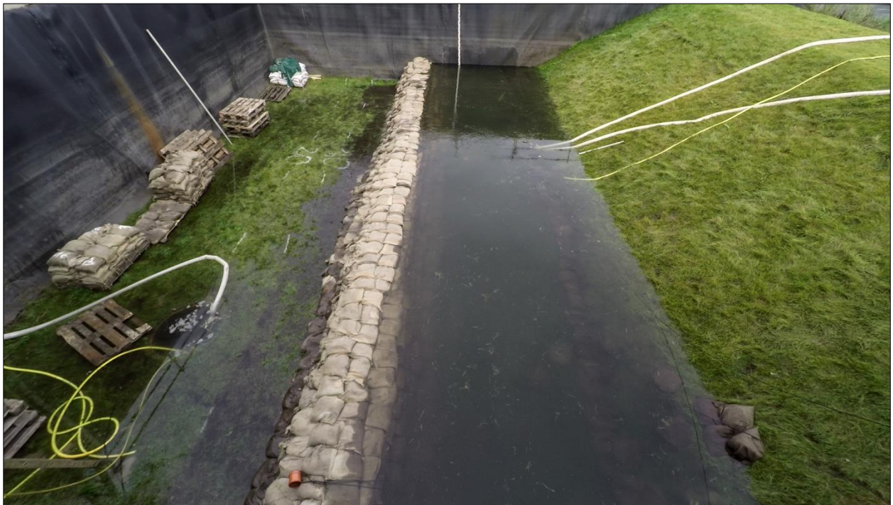
Abb. 7-10: Sandsackdamm – Maximale Einstauhöhe sowie Überschwemmung der wasserabgewandten Seite
