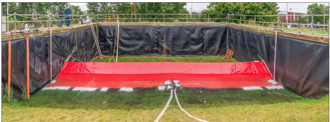
Abb. D-127: Plettac Aqua Defence – Belastungstest: Einstau mit einem Wasserstand von 0,60 m
