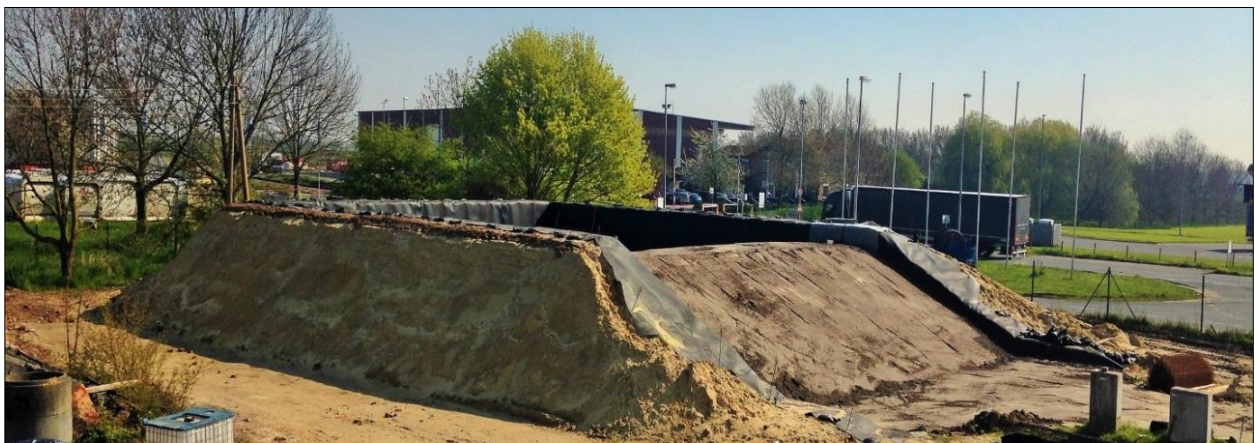
Abb. B-24: Fertiger Deichkörper einschließlich aufgebrachtter Mutterbodenschicht
