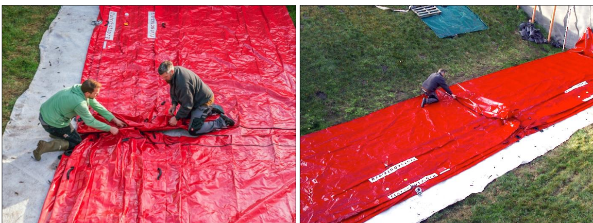
Abb. D-64: Flutschutz-Deichkade – Aufbau, Arbeitsschritte 3 und 4: Positionierung, Ausbreiten des Folgeelements und Verbindung der Systemenden mithilfe der Karabiner (links); Anbringen der Verbindungsschürze (rechts)
