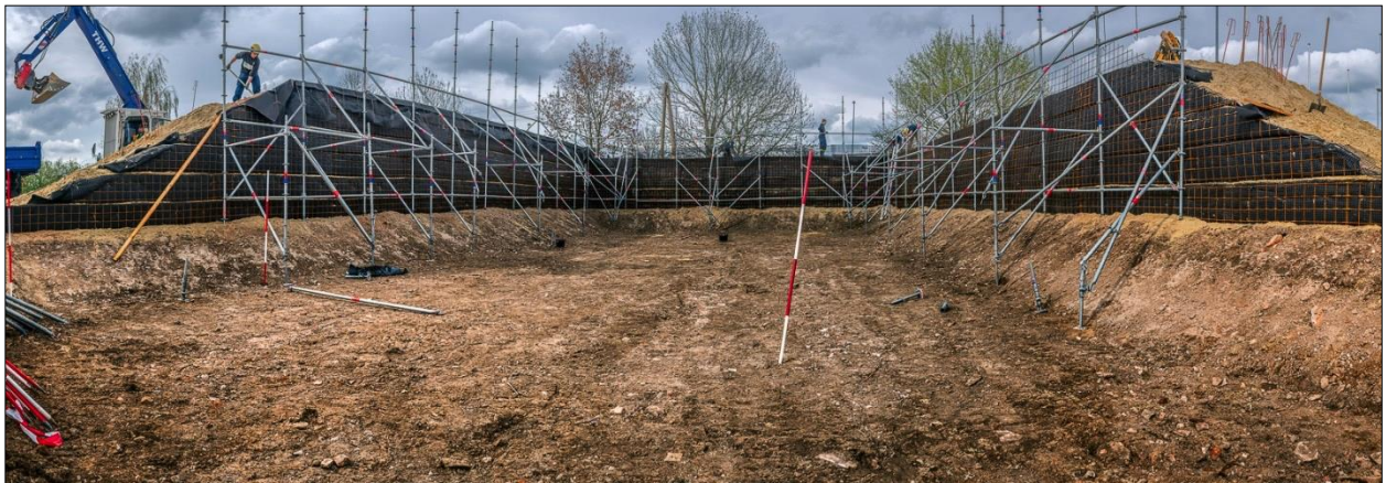
Abb. B-14: Installation der innenliegenden Absturzsicherung
