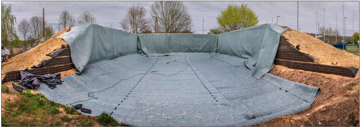
Abb. B-16: Verlegung eines Vlieses zum Schutz der Kunststoffdichtungsbahn
