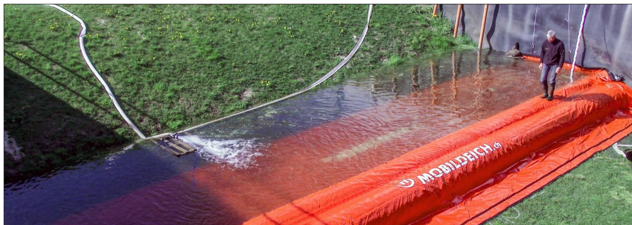
Abb. D-43: Mobildeich – Belastungstest: Dynamische Einwirkungen infolge Auf- und Ab-Bewegungen auf das volleingestaute Mobildeichsystem
