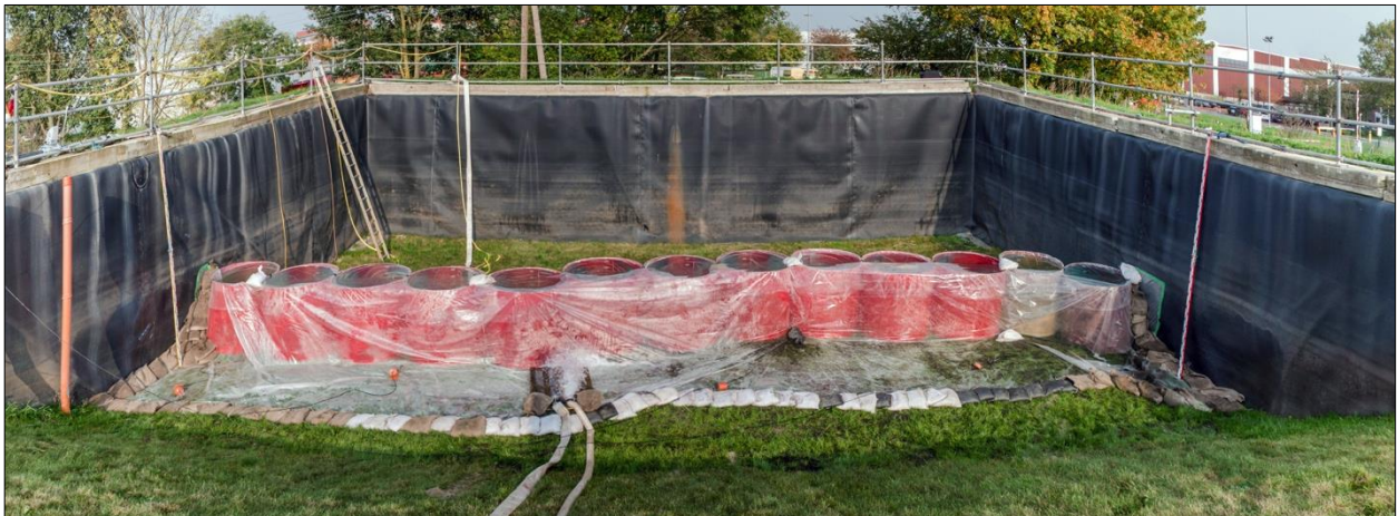
Abb. D-78: Aquariwa – Aufbau: Fertiggestellte Schutzlinie
