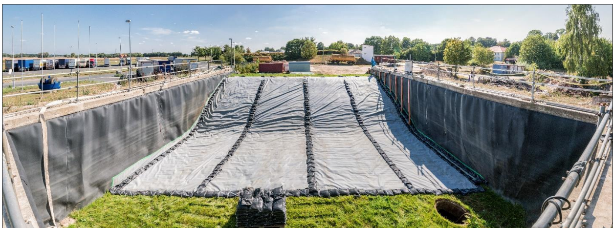
Abb. 5-26: Einstauversuch 4 – Installiertes Schutzsystem mit Sandsackbeschwerung entlang des Randbereichs und an den Elementstößen
