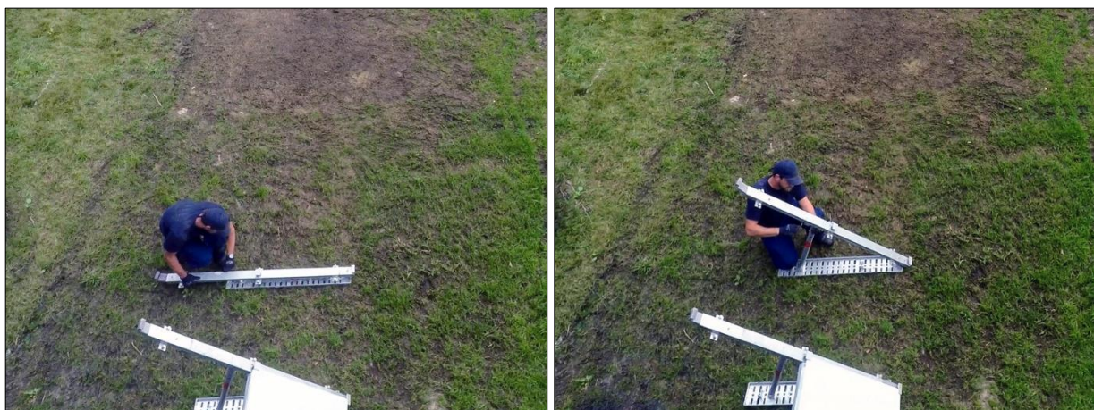
Abb. D-121: Plettac Aqua Defence – Aufbau, Arbeitsschritt 1: Auslegen (links) und Aufrichten sowie Arretieren der klappbaren Böcke (rechts)
