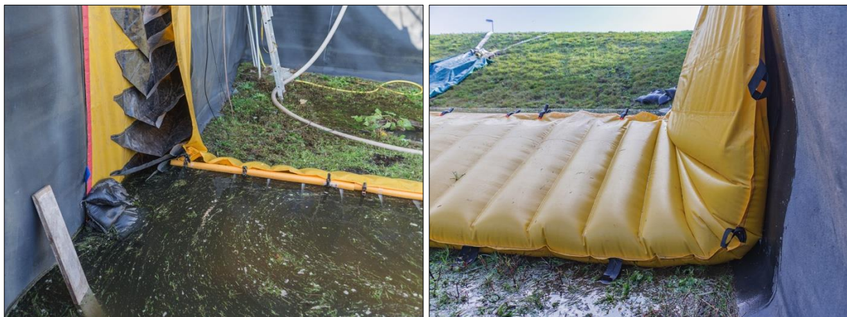
Abb. D-110: Megasecur Water-Gate – Belastungstest: Dichtung des Randbereichs im eingestauten Zustand
