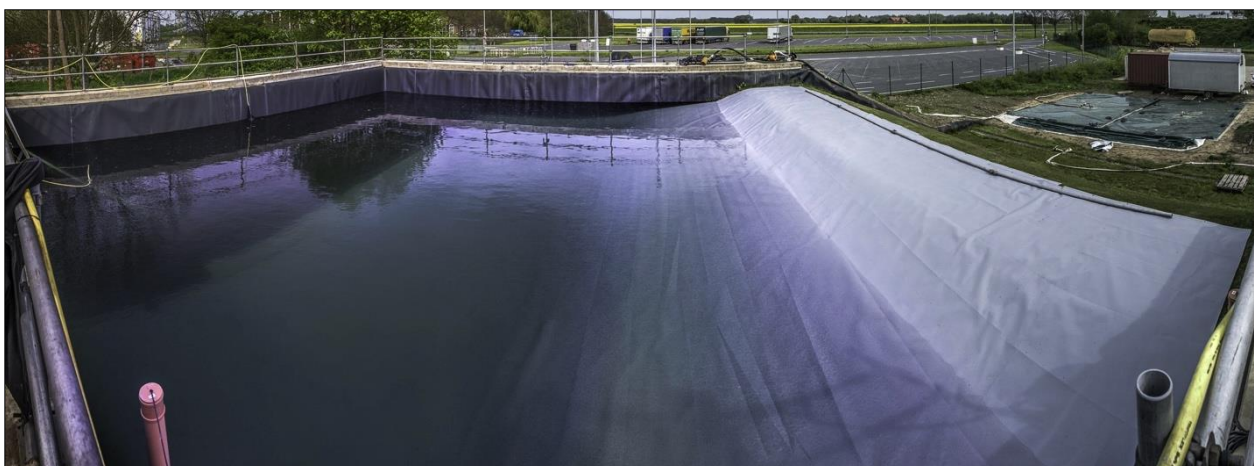
Abb. 5-11: Einstauversuch 1 – Installiertes Schutzsystem
