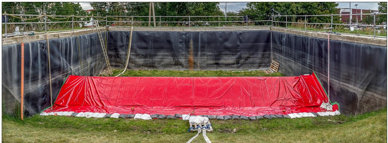
Abb. D-126: Plettac Aqua Defence – Aufbau: Fertiggestellte Schutzlinie
