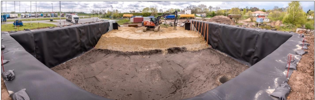
Abb. 4-2: Fertige Dichtung des Kunststoffbewehrten Erdwalls und Einbau des Deichbaumaterials
