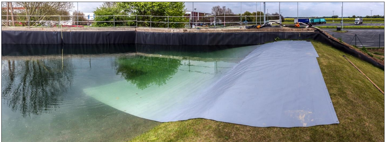
Abb. 5-10: Einstauversuch 1 – Aufbringen des zweiten Elements
