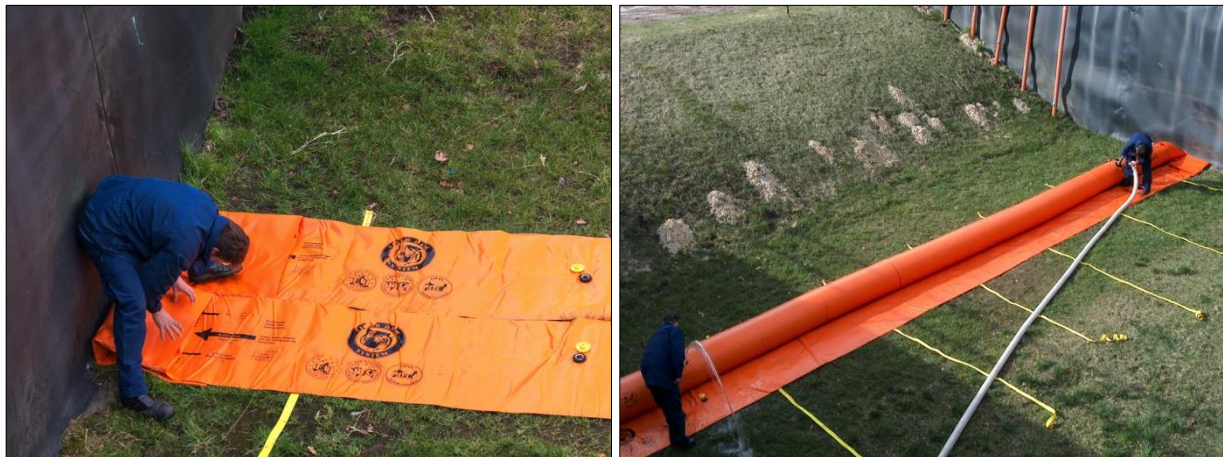
Abb. D-18: Tiger Dam – Arbeitsschritte 3 und 4: Zusammenfalten der Enden und Überziehen der Hussen (links); Befüllen der Tiger Dam Schläuche bis zum richtigen Füllgrad (rechts)
