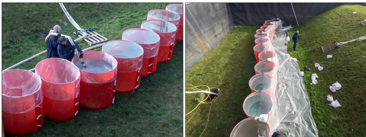
Abb. D-77: Aquariwa – Aufbau, Arbeitsschritte 5 und 6: Füllen der Zylinder (links); Installation der Dichtungsbahn sowie Beschwerung mit Sandsäcken (rechts)
