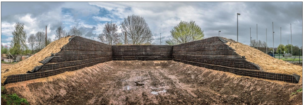
Abb. 4-1: Fertigstellung des Kunststoffbewehrten Erdwalls
