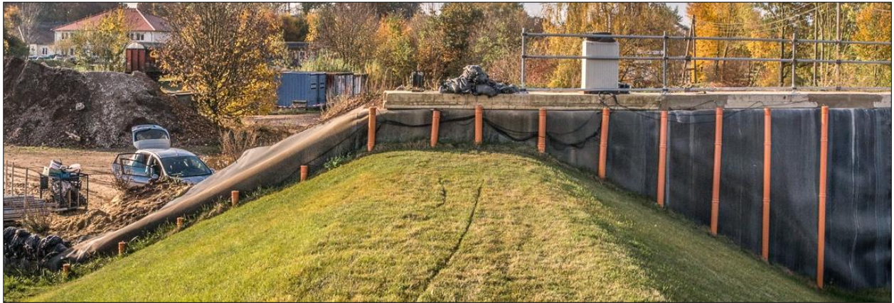
Abb. B-32: Messkonstruktion am Testdeich mit Pegelrohren
