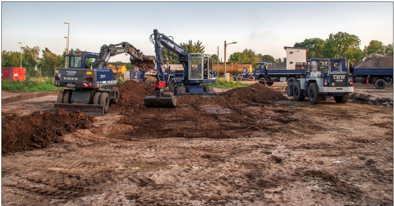
Abb. B-4: Begradigung der Fläche des Testgeländes
