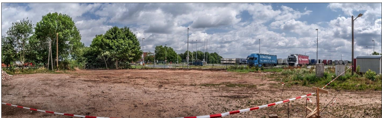
Abb. B-3: Fertiggestelltes Planum
