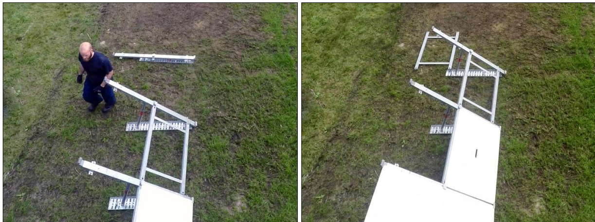
Abb. D-122: Plettac Aqua Defence – 2. und 3. Arbeitsschritt: Einsetzen des Aussteifungsrahmens (links); Einbau der Hartschaumplatte (rechts)
