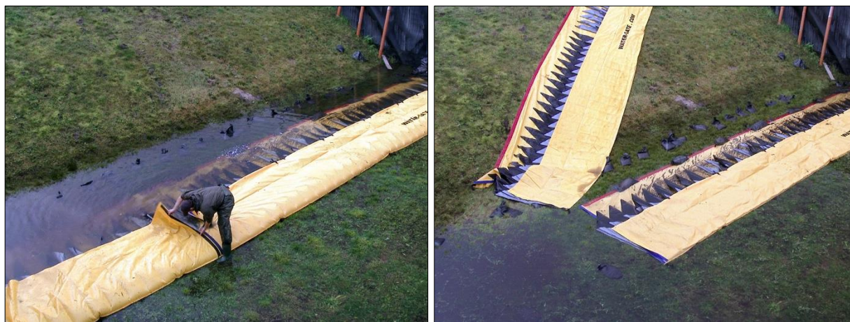
Abb. D-116: Megasecur Water-Gate – Rückbau, Arbeitsschritte 1 und 2: Entnahme der Sandsäcke und Öffnung der Klettverbindung (links); Positionierung des Systemelements auf der Böschung für den freien Auslauf des Restwassers (rechts)
