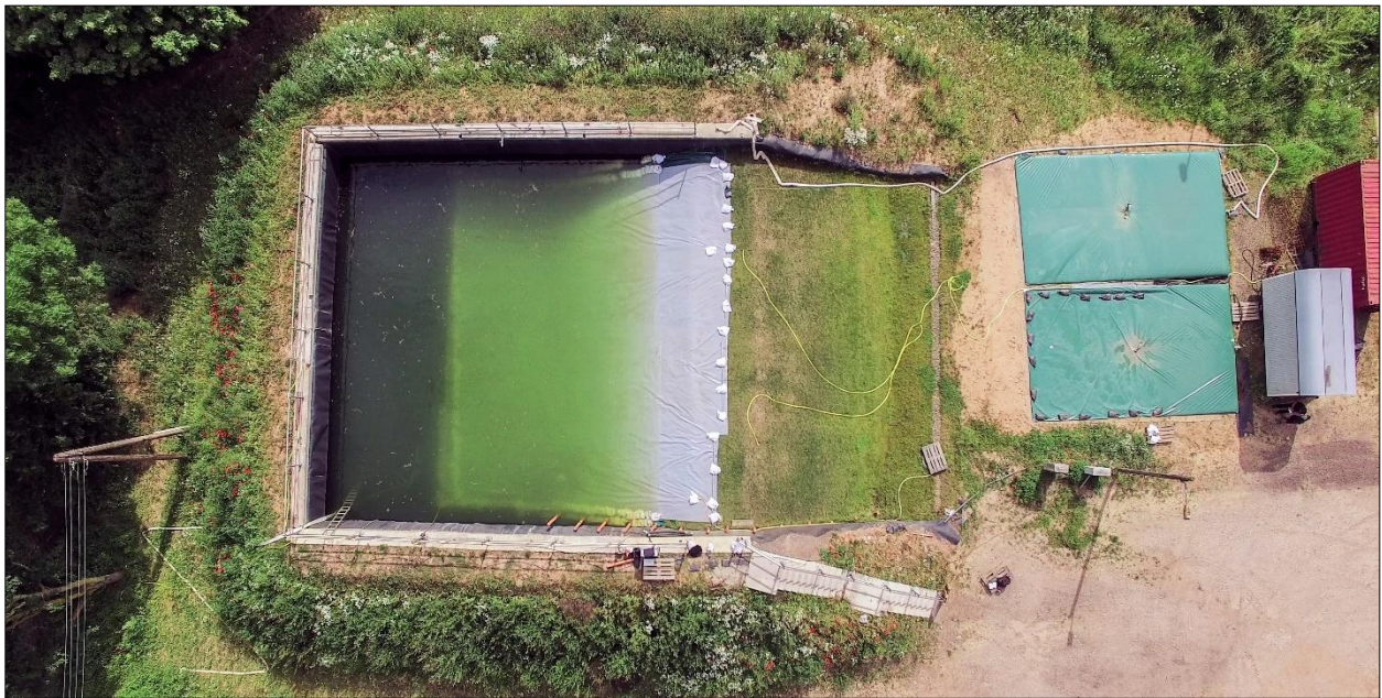
Abb. 5-20: Einstauversuch 3 – Beschwerung des Schutzsystems im Randbereich mit Hilfe von Sandsäcken
