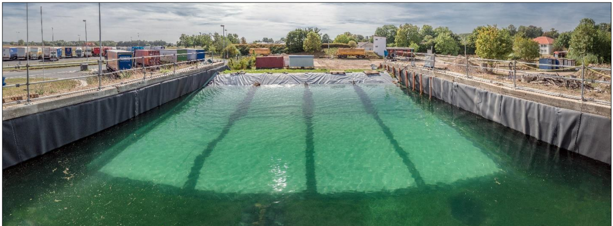
Abb. 5-27: Einstauversuch 4 – Installiertes Schutzsystem mit nachträglich eingebrachten Sandsäcken entlang der Elementstöße
