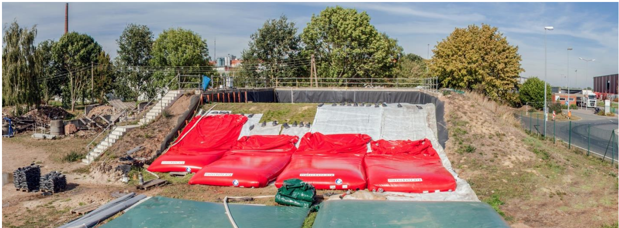
Abb. 5-40: Ansicht des fertiggestellten Flutschutz-Auflastfilters
