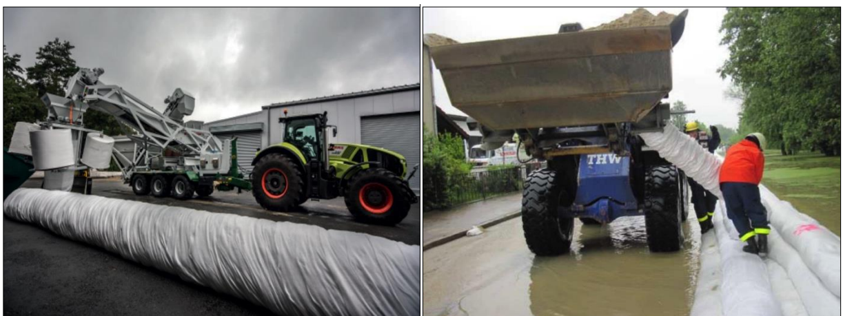
Abb. 6-15: Aufbau eines ummantelten Sandschlauchs mit speziell entwickelter Maschine (links), (topocare, 2020); Aufbau eines Sandschlauches mit aufgerafften Geotextilschläuchen und einer umgebauten Radladerschaufel (rechts), (THW, 2014)
