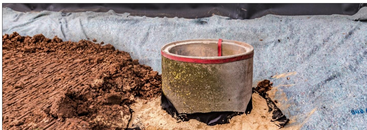
Abb. B-20: Einbau des Wasserseitigen Sickerschachtes
