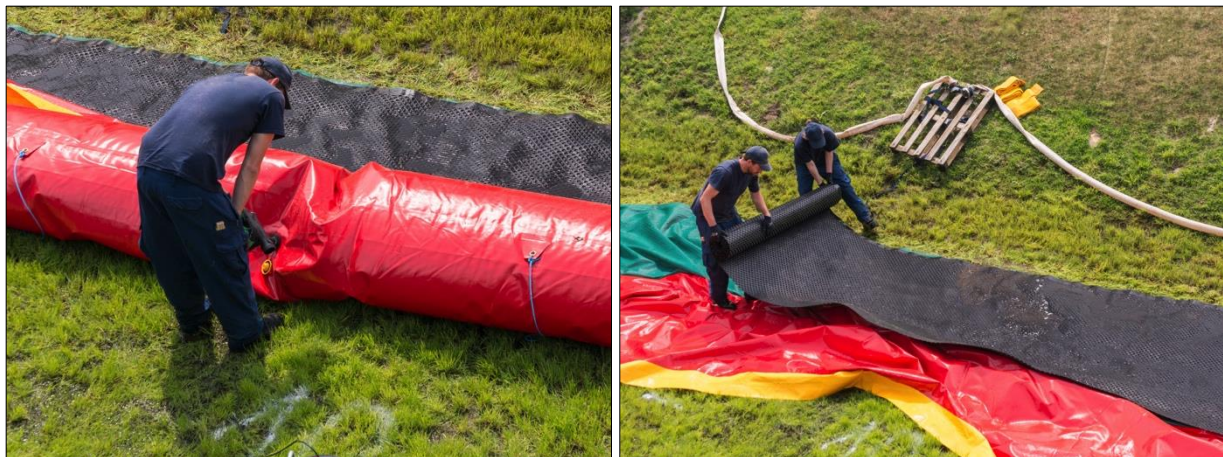
Abb. D-60: Öko-Tec-Schlauchwall – Rückbau, Arbeitsschritte 3 und 4: Restentleerung der Schläuche mithilfe des Luftgebläses (links); Aufrollen der Noppenbahn (rechts)
