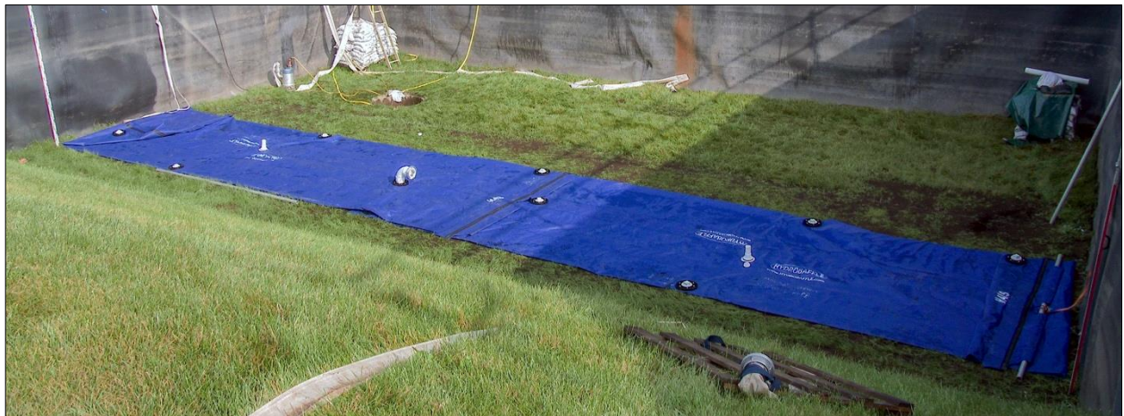
Abb. D-3: Hydrobaffle – Aufbau, Arbeitsschritte 2 und 3: Ausbreiten des nachfolgenden System-Elements unter Einhaltung der geforderten Überlappungslänge; Einbau der Einfüllwinkel und Überlaufrohre sowie Kontrolle, ob die seitlichen Ventile geschlossen sind.
