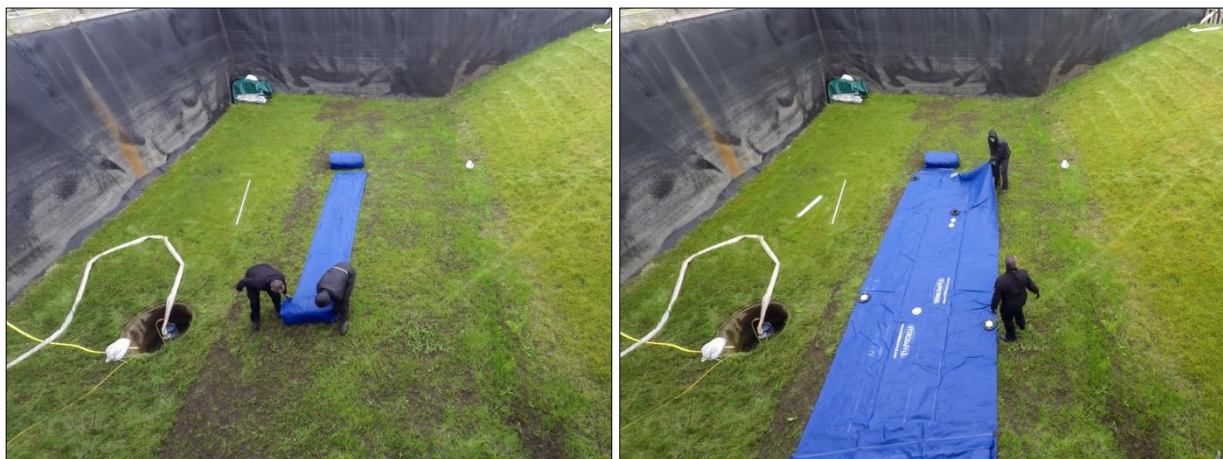
Abb. D-2: Hydrobaffle – Aufbau, Arbeitsschritt 1: Ausrollen (links) und Auseinanderfalten des Hydrobaffles (rechts)
