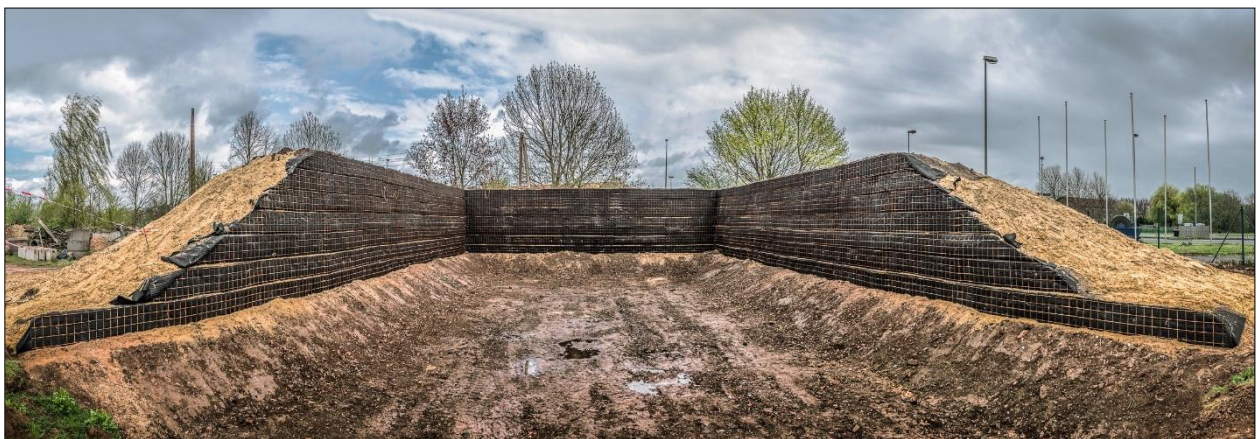
Abb. B-15: Fertigstellung des Kunststoffbewehrten Erdwalls
