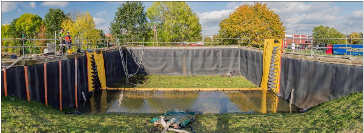
Abb. D-111: Megasecur Water-Gate – Belastungstest: Einstau mit einem Wasserstand von 0,60 m
