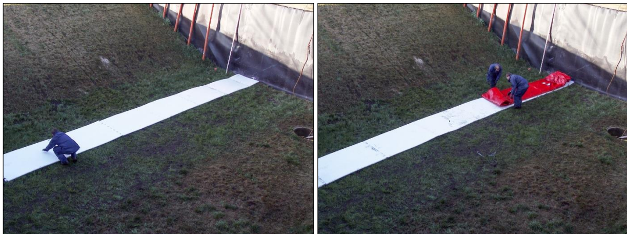
Abb. 7-13: Flutschutz-Doppelkammerschlauch – Aufbau, Arbeitsschritte 1 und 2: Auslegen der PE-Schaumstoffmatten entlang der Schutzlinie (links); Positionieren des Systems auf der PE-Schaumstoffmatte und Ausrollen sowie Auseinanderfalten (rechts)
