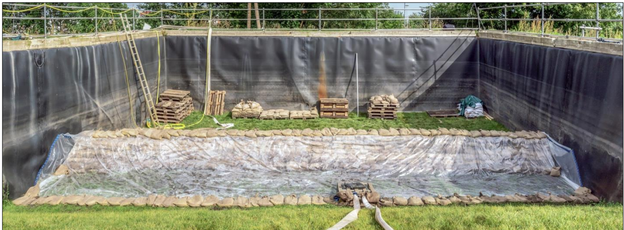
Abb. 7-4: Sandsackdamm – Fertiggestellter Sandsackdamm mit vorgelagerter Dichtungsbahn auf der Wasserseite
