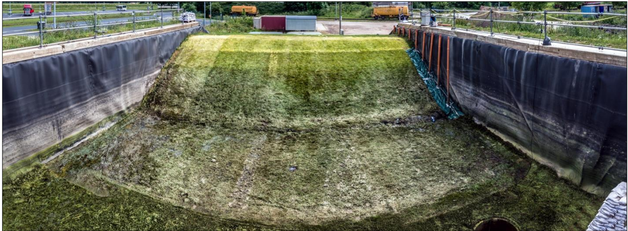
Abb. 5-24: Einstauversuch 3 – Zustand der Rasenoberfläche nach Rückbau des Schutzsystems
