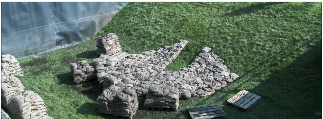
Abb. 5-48: Abgeschlossener Aufbau der zweiten Lage der Sandsack-Quellkade
