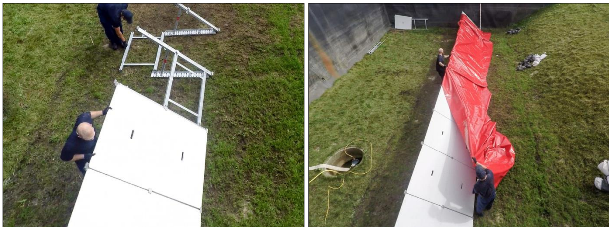
Abb. D-123: Plettac Aqua Defence – Aufbau, 4., 5. und 6. Arbeitsschritt: Einsetzen der oberen Hartschaumplatte (links); Installation der Schutzplane (rechts)
