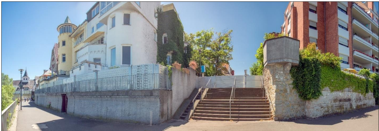
Abb. 2-17: Mobiles Dammbalkensystem in Köln Rodenkirchen
