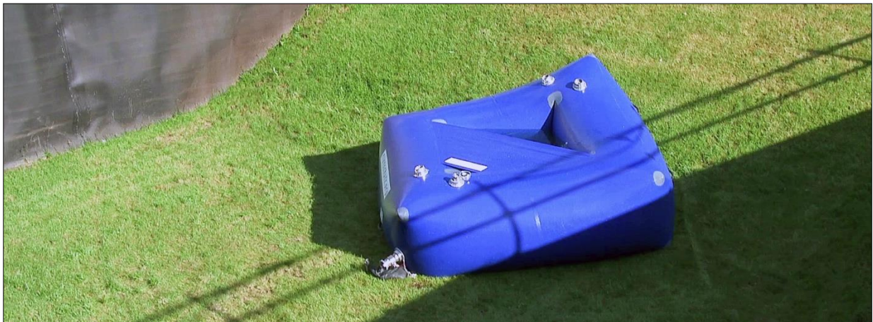
Abb. 5-53: Fertiggestellte Flutschutz-Quellkade
