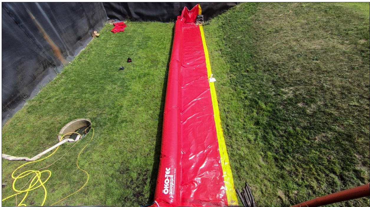
Abb. D-53: Öko-Tec-Schlauchwall – Aufbau: Fertiggestellte Schutzlinie
