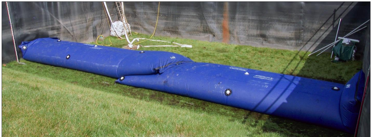
Abb. D-5: Hydrobaffle – Aufbau: Fertiggestellte Schutzlinie
