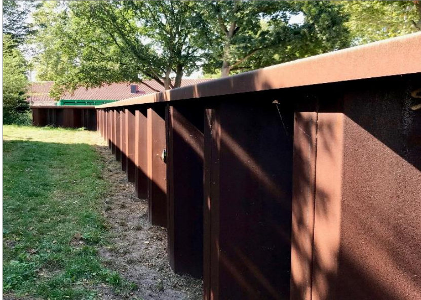
Abb. A-5: Stützwand mit Spundbohlen
