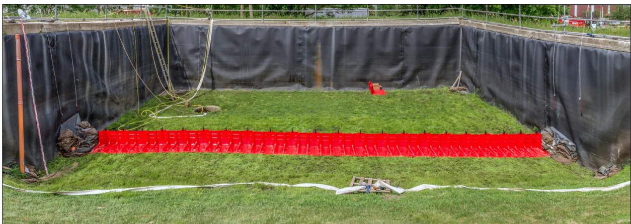
Abb. D-140: NOAQ Boxwall – Aufbau: Fertiggestellte Schutzlinie
