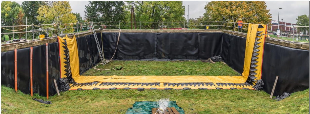
Abb. D-108: Megasecur Water-Gate – Aufbau: Fertiggestellte Schutzlinie
