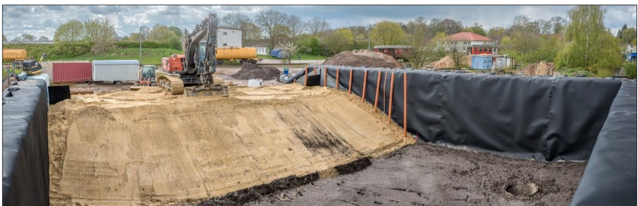
Abb. B-23: Profilierung des Testdeichs
