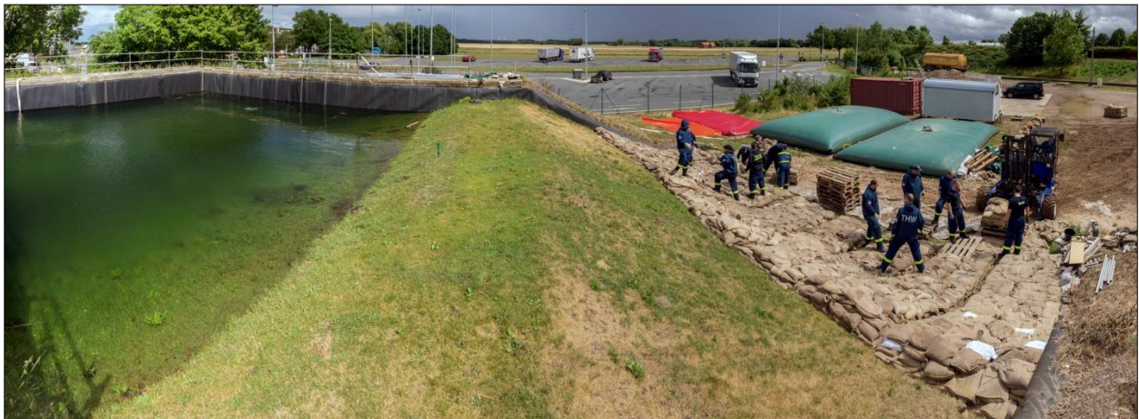
Abb. 5-32: Aufbau der letzten Lage des Sandsack-Auflastfilters mit Helfern des THW
