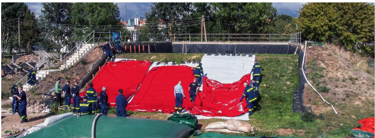
Abb. 5-39: Aufbau des Flutschutz-Auflastfilters mit Hilfe vom THW
