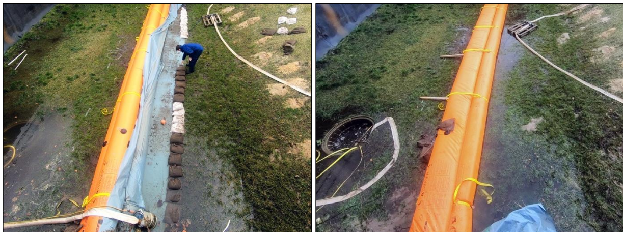
Abb. D-30: Tiger Dam – Rückbau, Arbeitsschritte 1 und 2: Entnahme der Sandsäcke sowie der vorgelagerten Dichtungsbahn (links); Öffnen des Ventils vom obenliegenden Schlauch, Lösen der Befestigung und Entfernung der Erdanker (rechts)
