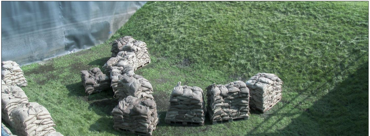
Abb. 5-47: Bereitgestellte Sandsäcke für den Bau der Sandsack-Quellkade
