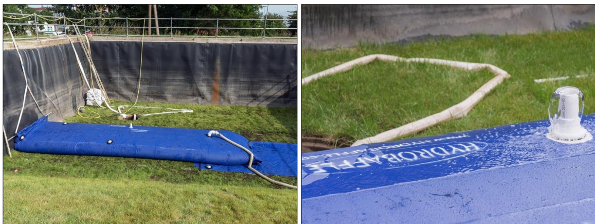
Abb. D-4: Hydrobaffle – Aufbau, Arbeitsschritt 4: Füllen des obenliegenden Hydrobaffles (links), bis Wasser aus dem Überlaufrohr tritt (rechts)
