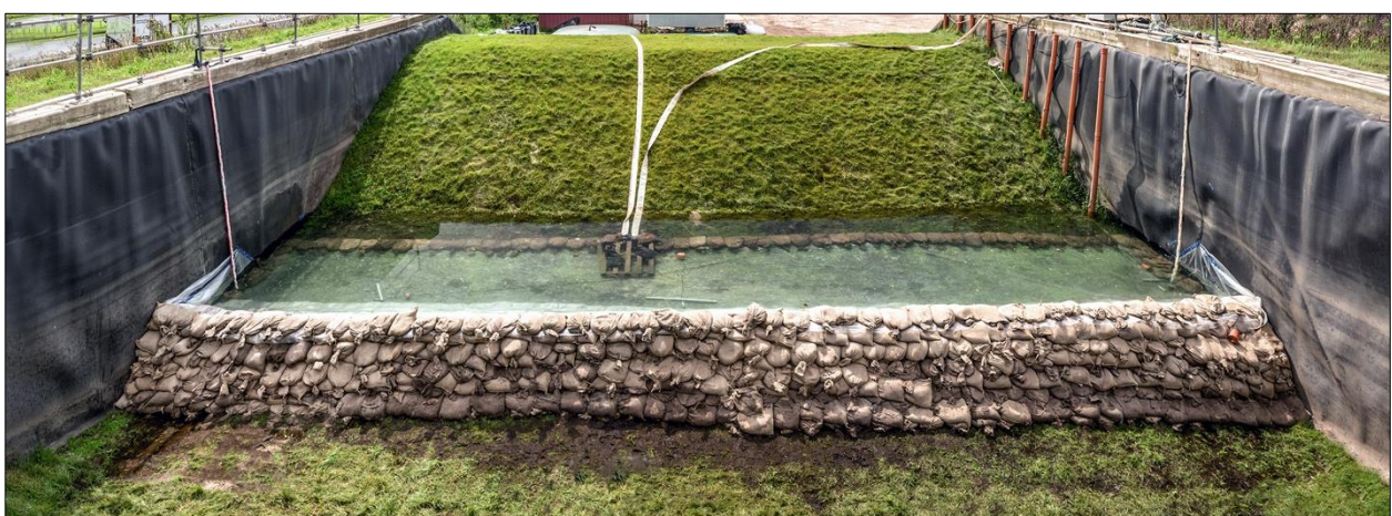
Abb. 7-5: Sandsackdamm – Einstau mit vorgelagerter Dichtungsbahn auf der Wasserseite und einem Wasserstand von 0,60 m, (Massolle et al., 2018)
