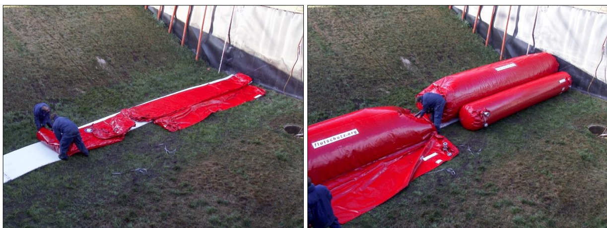
Abb. 7-14: Flutschutz-Doppelkammerschlauch – Aufbau, Arbeitsschritte 3 und 4: Positionierung, Ausrollen und Auseinanderfalten des Folgeelements (links); Füllen der Kammern mit Luft (rechts)
