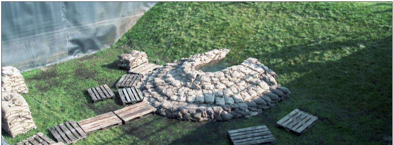
Abb. 5-49: Fertiggestellte Sandsack-Quellkade
