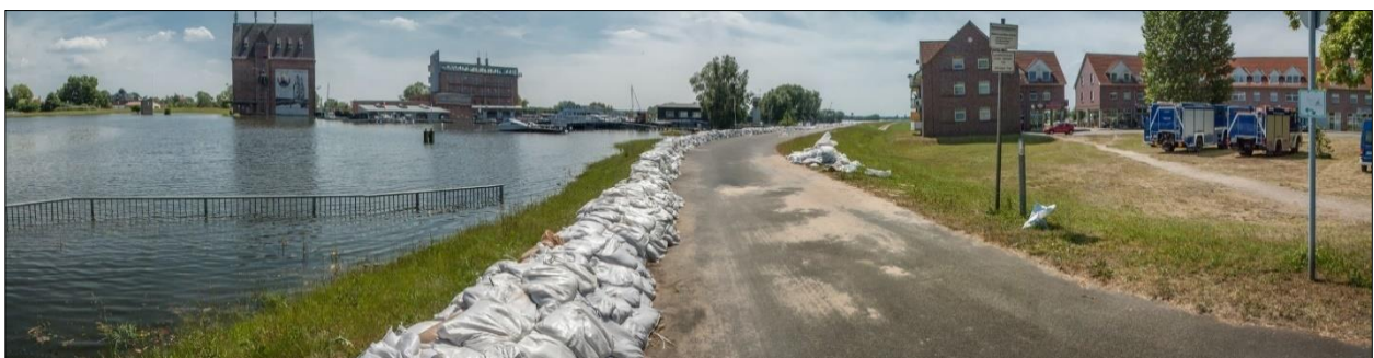
Abb. 1-2: Sandsackdamm beim Elbehochwasser 2013 (Foto: Bärbel Koppe)
