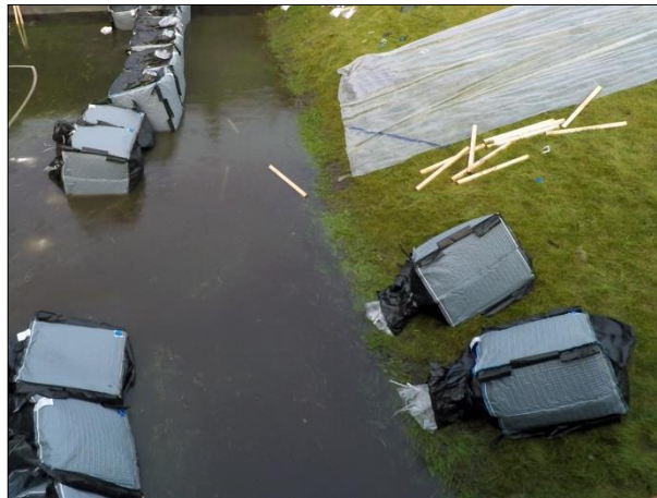
Abb. D-100: Indutainer – Rückbau, Arbeitsschritt 5: Verzurren des innenliegenden Foliensacks und der Außenhülle mit Kabelbindern bzw. Schnüren
