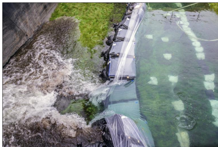
Abb. D-96: Indutainer – Belastungstest: Überströmung des versagten Indutainer-Systems
