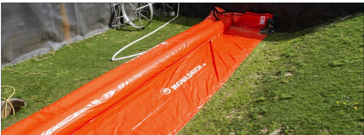
Abb. D-39: Mobildeich – Aufbau: Fertiggestellte Schutzlinie
