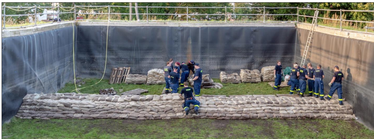
Abb. 7-3: Sandsackdamm – Aufbau der Lage 7 und Lage 8
