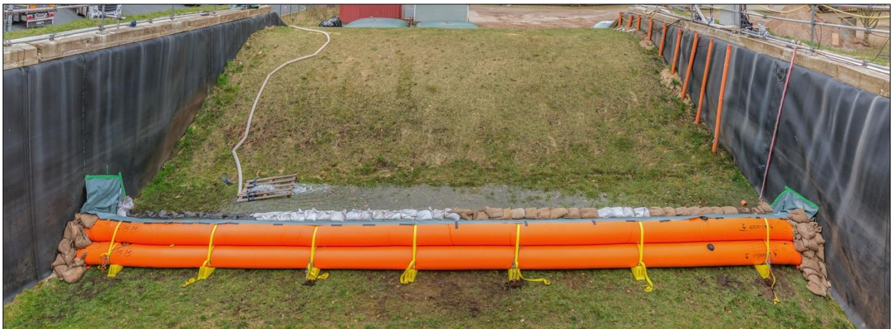
Abb. D-22: Tiger Dam – Aufbau: Fertiggestellte Schutzlinie mit vorgelagerter Dichtungsbahn und Bodenverankerung
