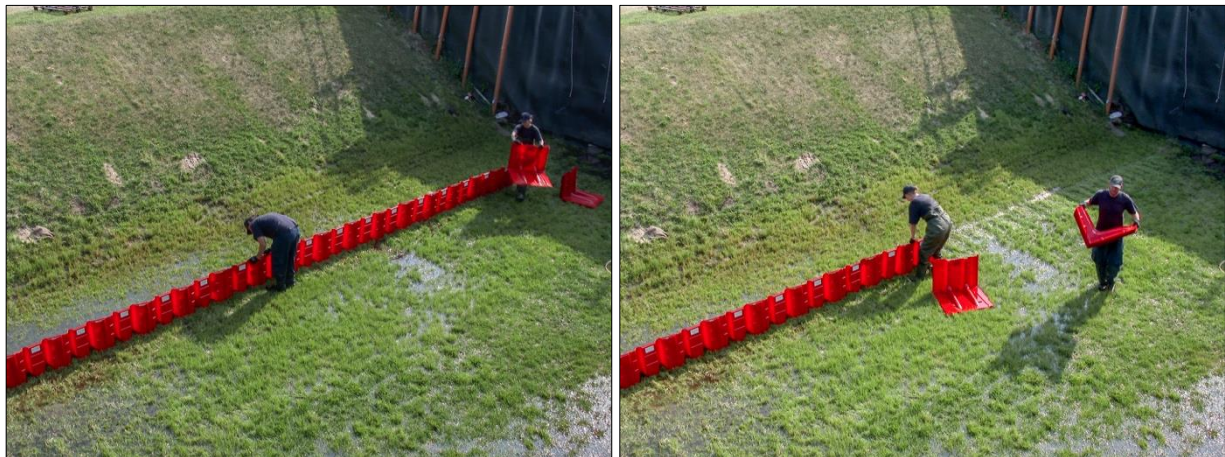
Abb. D-145: NOAQ Boxwall – Rückbau, 1. und 2. Arbeitsschritt: Entnahme der Klemmzangen (links) und Wegtragen der einzelnen Systemelemente (rechts)
