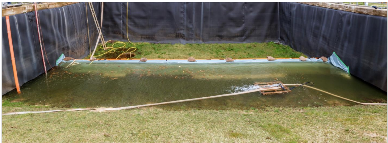
Abb. D-28: Tiger Dam – Belastungstest: Volleinstau des Tiger Dam-Systems bei einem Wasserstand von 0,79 m
