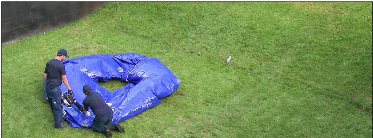
Abb. 5-50: Arbeitsschritt 1 – Befüllung der Flutschutz-Quellkade mit Luft
