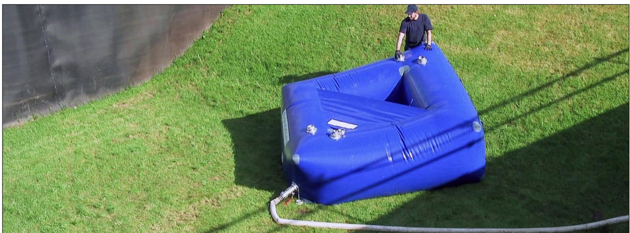
Abb. 5-52: Arbeitsschritt 3 – Füllen der Flutschutz-Quellkade mit Wasser bei gleichzeitiger Entlüftung
