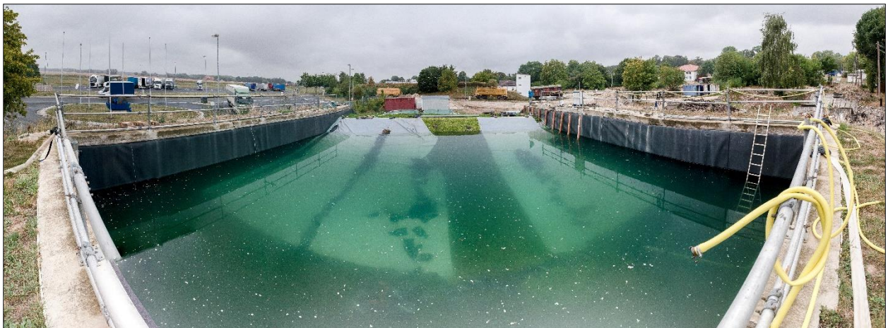
Abb. 5-28: Einstauversuch 4 – Entnahme des Schutzsystems
