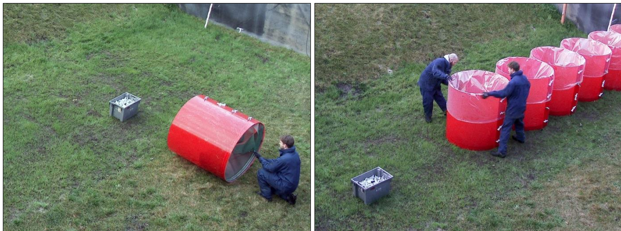
Abb. D-76: Aquariwa – Aufbau, Arbeitsschritte 3 und 4: Zusammenziehen des Gitternetzes (links); Aufstellen des Zylinders und Einbringen des Foliensacks (rechts)
