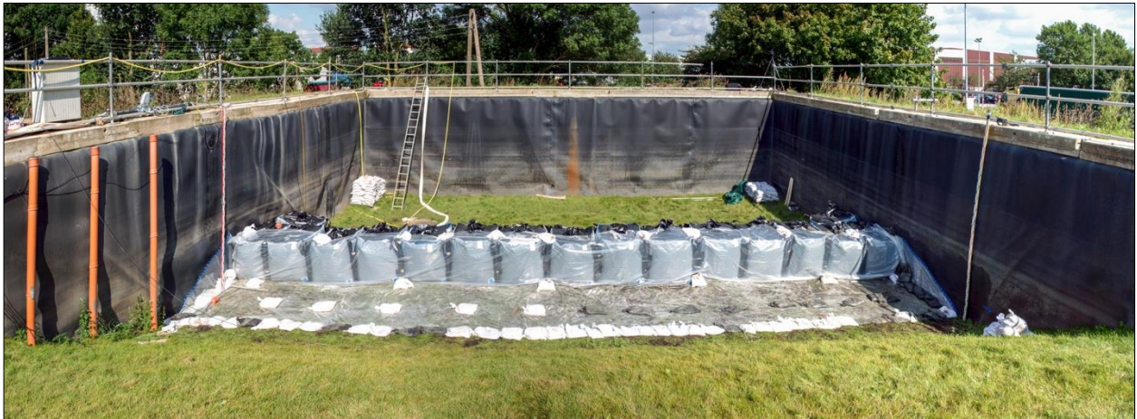
Abb. D-91: Indutainer – Aufbau: Fertiggestellte Schutzlinie mit vorgelagerter Dichtungsbahn
