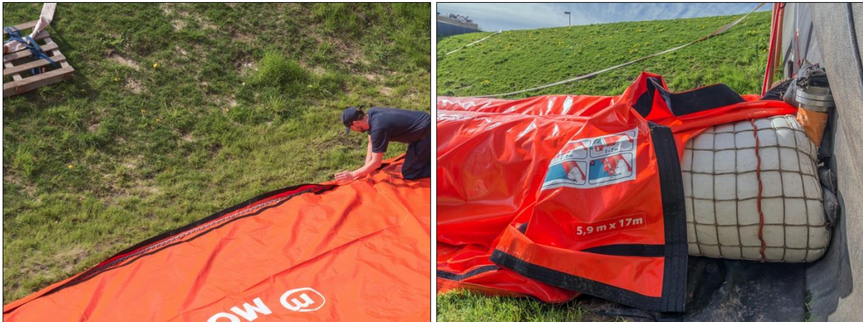
Abb. D-38: Mobildeich – Aufbau, Arbeitsschritte 7 und 8: Lagesicherung der Stahlkette durch Umschlagen und Fixierung der Dichtungsbahn mit der Klettverbindung (links); Abdichtung des Randbereichs durch eigenständiges Anpressen der Stirnseite durch die Wasserfüllung (rechts)
